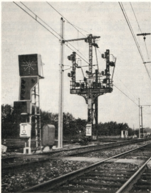
UN NOUVEAU SIGNAL DE BIFURCATION DE LA S. N. C. B. — A REMARQUER, AU SECOND PLAN, L'ANCIEN SEMAPHORE A PALETTES QU'IL REMPLACE
