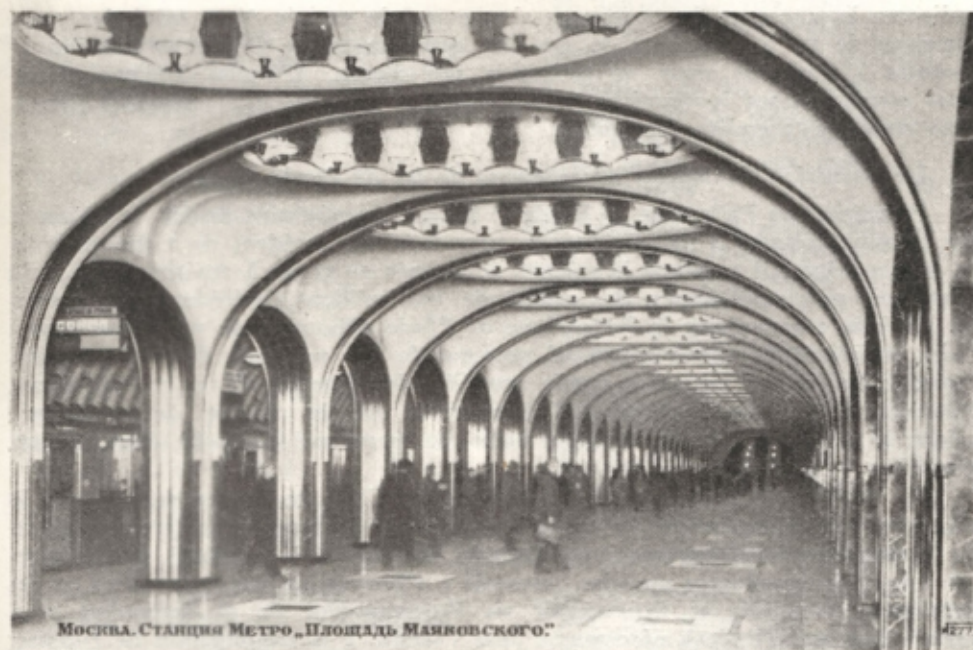
Une station du métro de Moscou - à gauche, une rame en stationnement.
