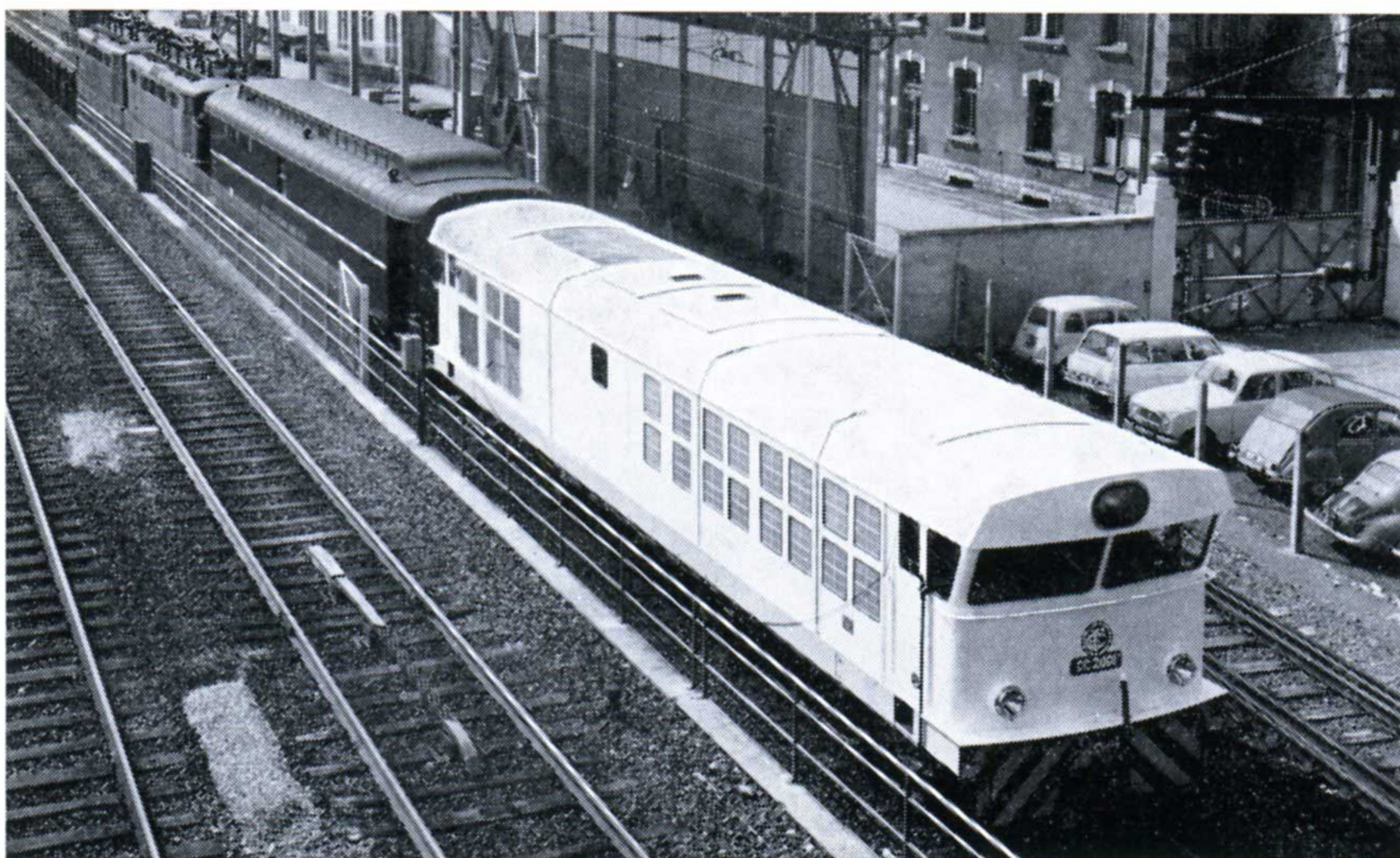
Locomotive Diesel-électrique CC 2400 pour la Régie des Chemins de fer Franco-Ethiopiens — vue prise à Belfort (France) au cours des essais. On remarque, derrière, la voiture électrotechnique de la S.N.C.F. et les deux BB électriques 16500 récupérant sur le réseau.
