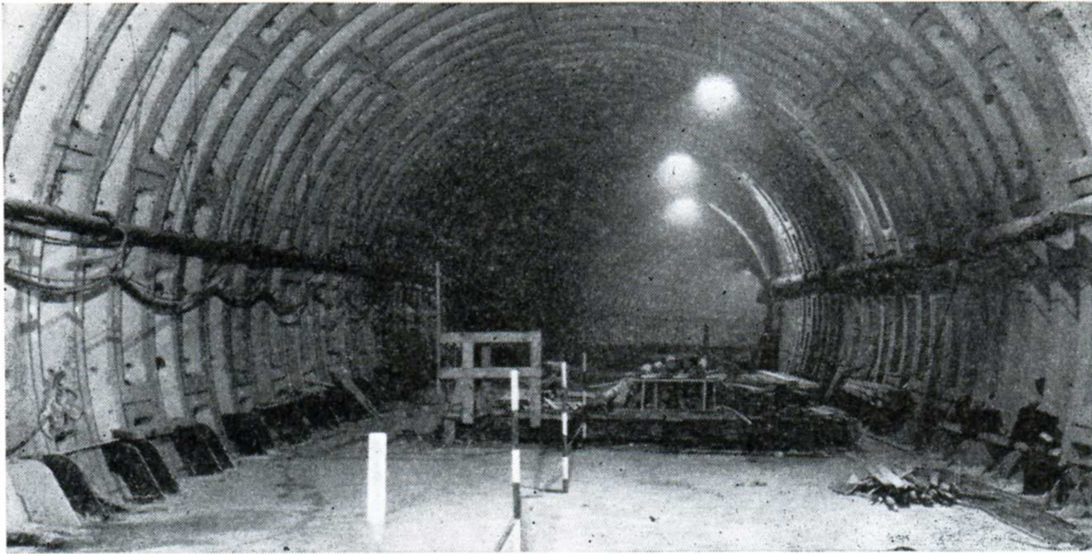
ligne n° 1 du métro de Bruxelles — tunnel construit au bouclier sous le Parc de Bruxelles — entrée de courbe engageant l'ouvrage sous la rue de la Loi en direction du Cinquantenaire.
