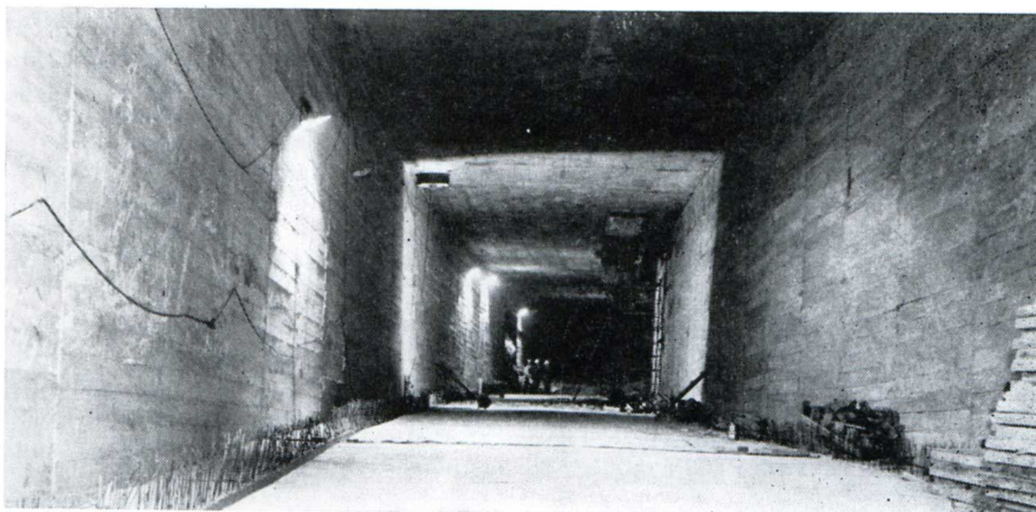
ligne no 2 du métro de Bruxelles — tunnel entre les stations « Madou » et « Arts-Loi ».
