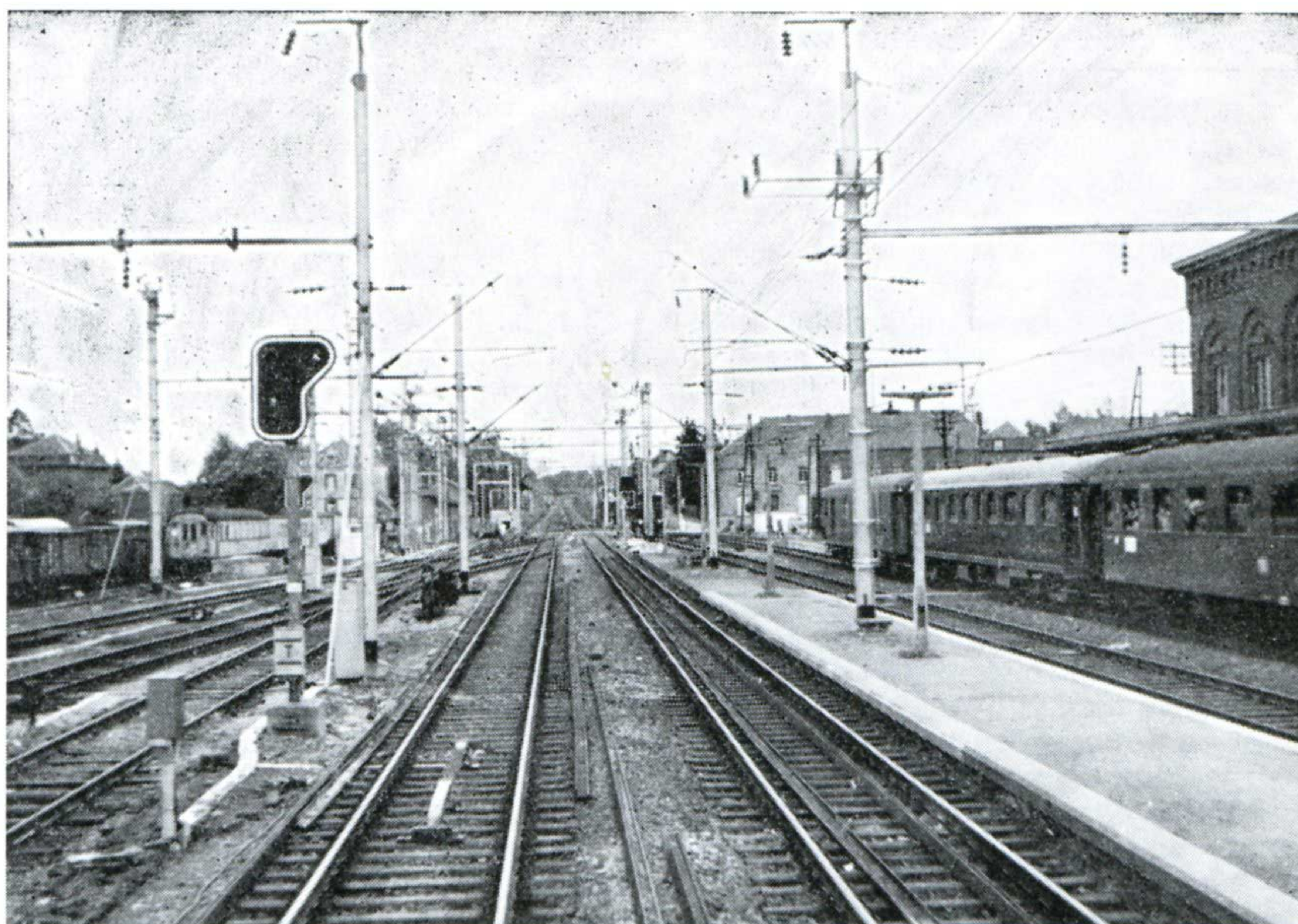
gare-frontière bi-courant 3.000 V courant continu et 25.000 V 50 Hz à Quévy. (cliché A.R.B.A.C. n°91)
