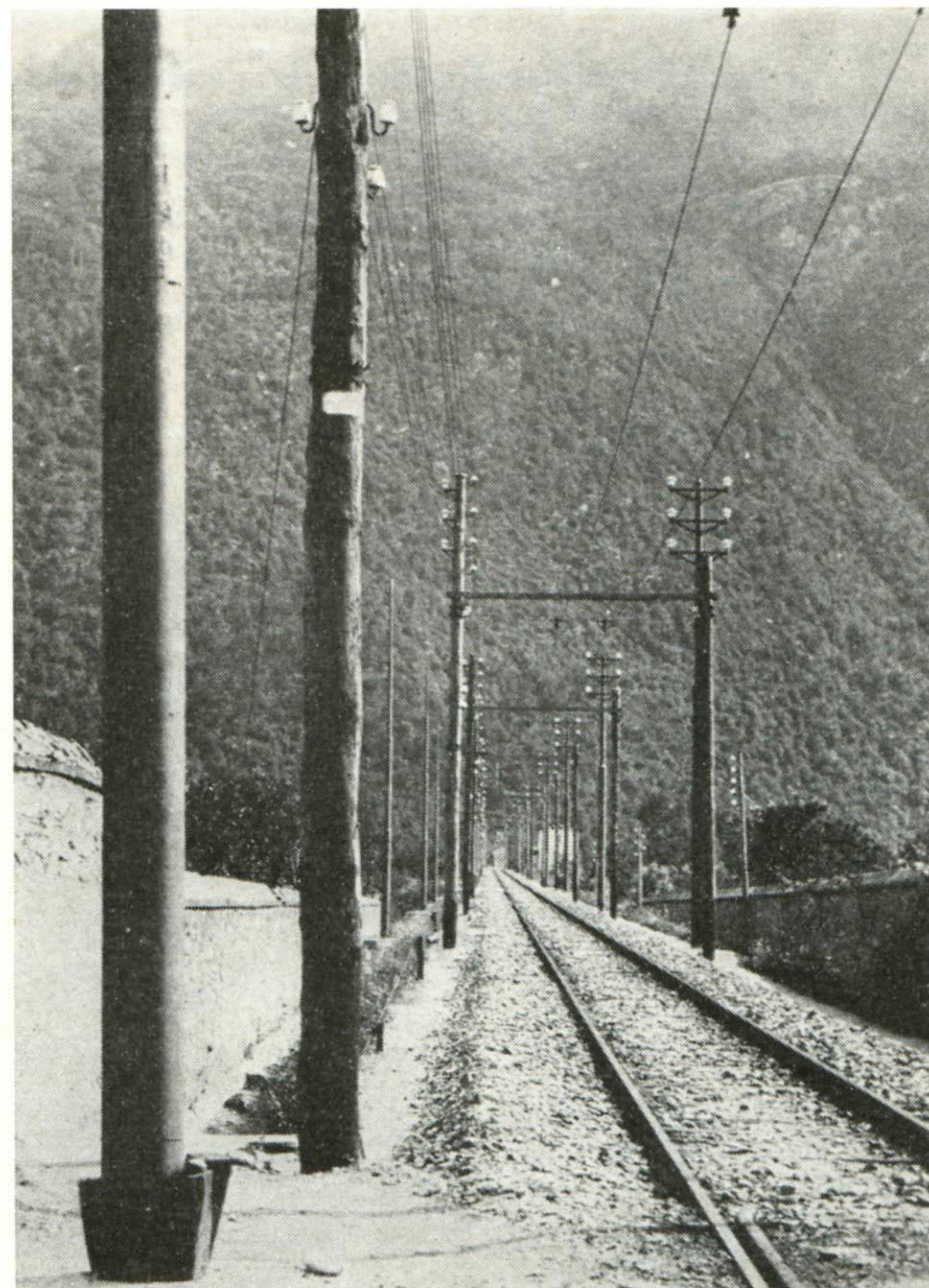
la ligne de la Valteline et la caténaire originale à poteaux de bois, en rampe de 22 ‰ (1902).
