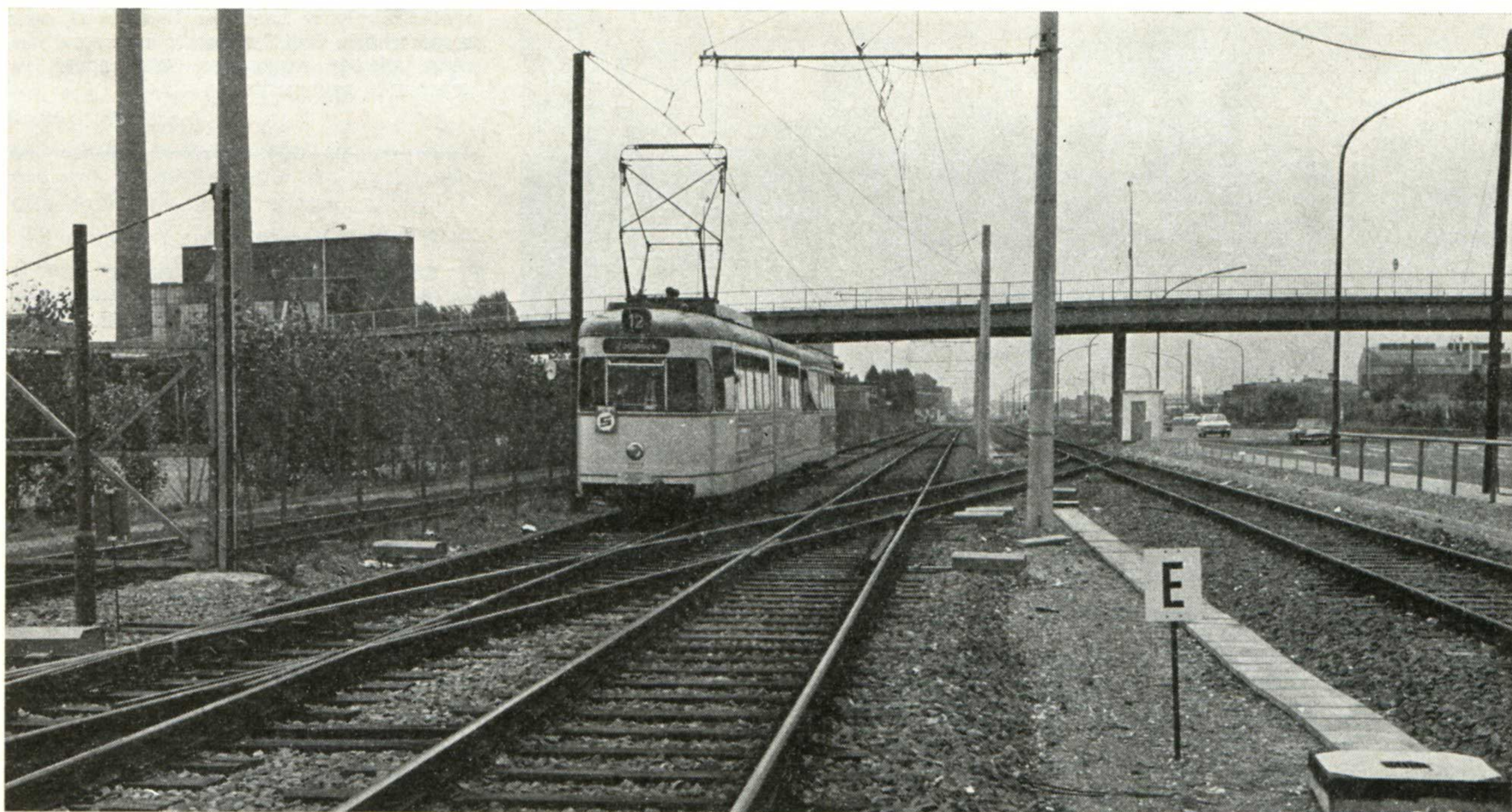
nouveau tronçon sur siège indépendant au Nord de Cologne, à Niehl, en bordure des nouvelles usines de la Fordwerke; ce tronçon et un autre, en site propre, ont permis de remplacer 5 lignes d'autobus par 2 lignes de tramway. (photo de l'auteur)
