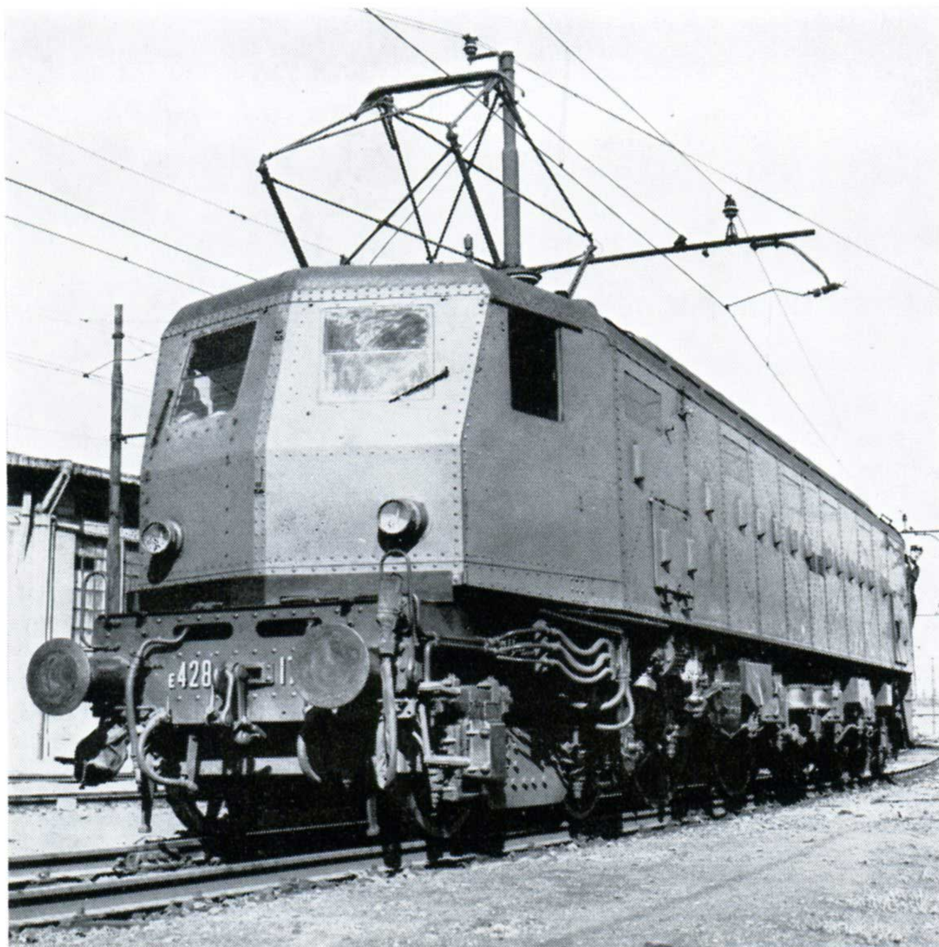
Locomotive électrique Gr.E.428, deuxième série, courant continu 3.000 V. des F.S.
