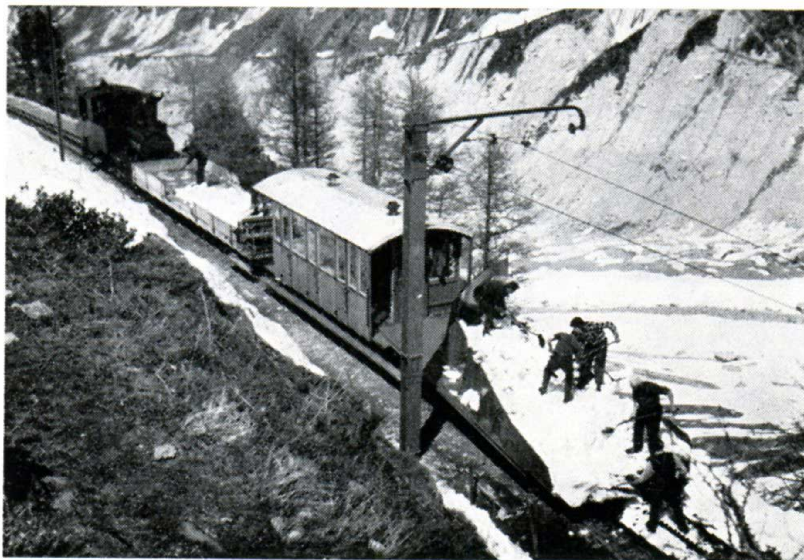
travaux de déneigement au Montenvers.
