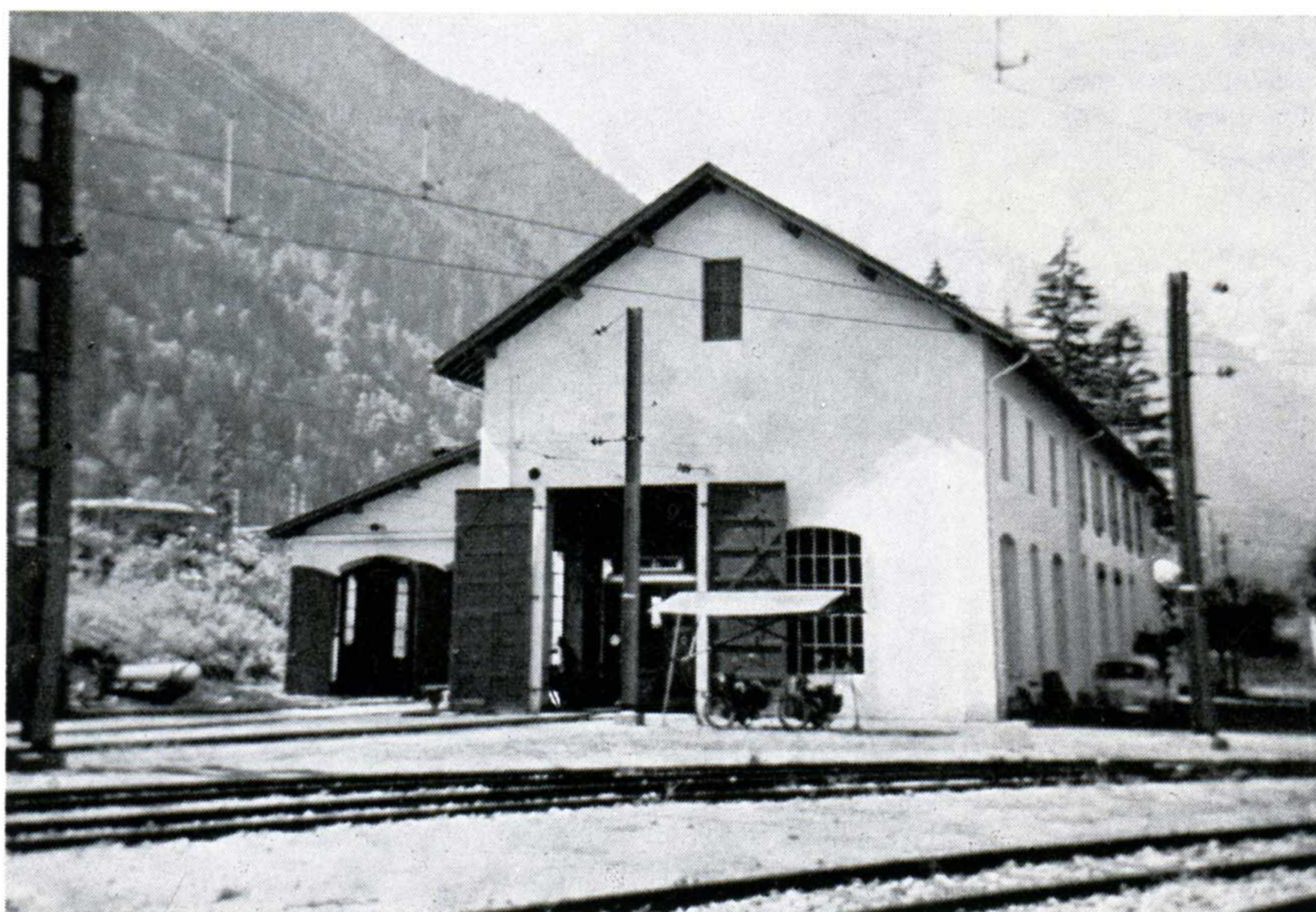
atelier et sous-station à Chamonix.
