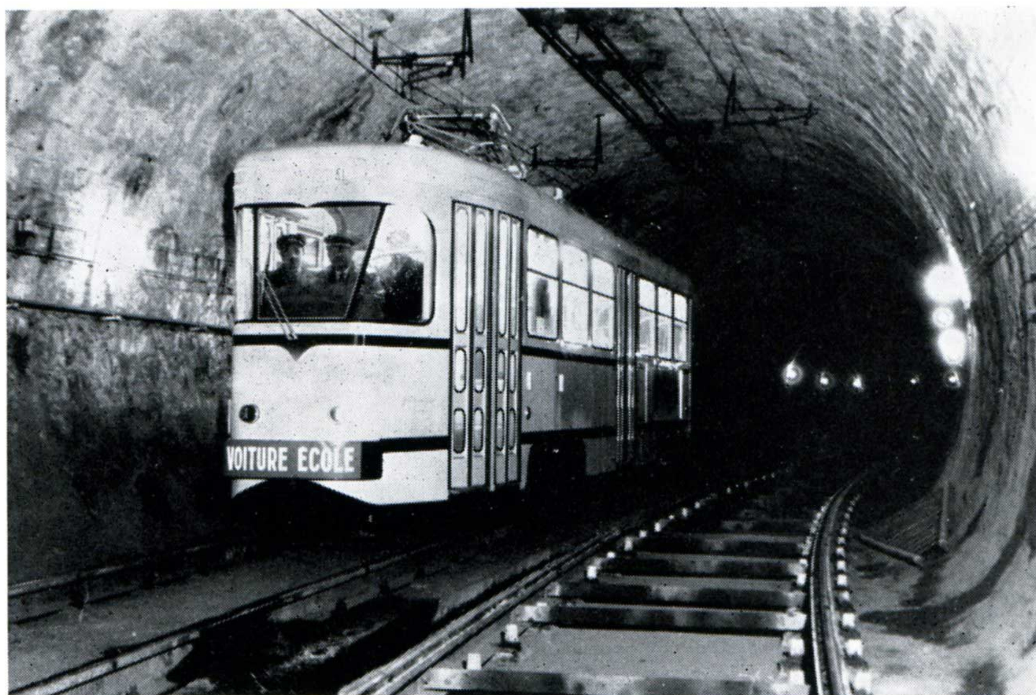
fig. 10 - Voiture PCC en écolage dans le tunnel de Noailles. (photo R. Martin)
