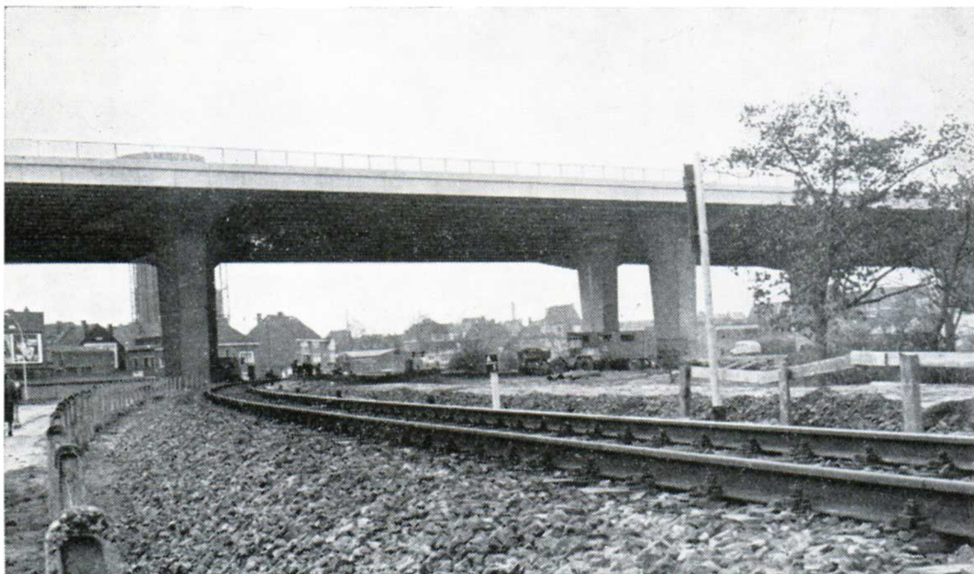
Le nœud ferroviaire de Gand est en pleine évolution; il prépare le « Régional » de demain, élément essentiel d'une bonne desserte urbaine; voici une voie unique provisoire au départ de Gentbrugge-Sud et sous l'ouvrage routier de l'autoroute Anvers-Lille
