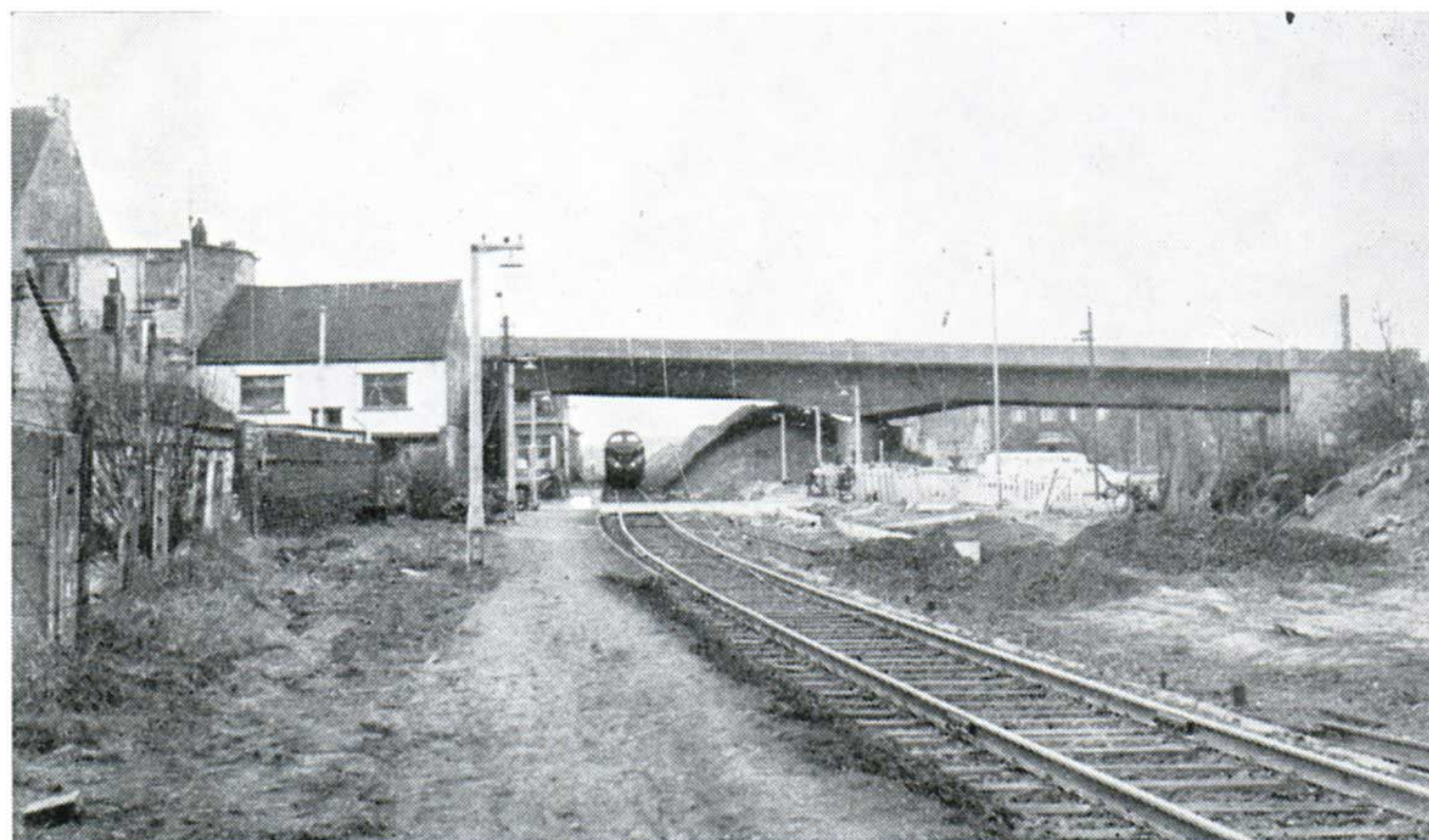
Malgré l'importance des travaux routiers liés à la rénovation du réseau gantois, les dessertes ferroviaires, indispensables, restent maintenues, même à voie unique, et notamment sur Gentbrugge-Sud (photos R. Boddewijn)
