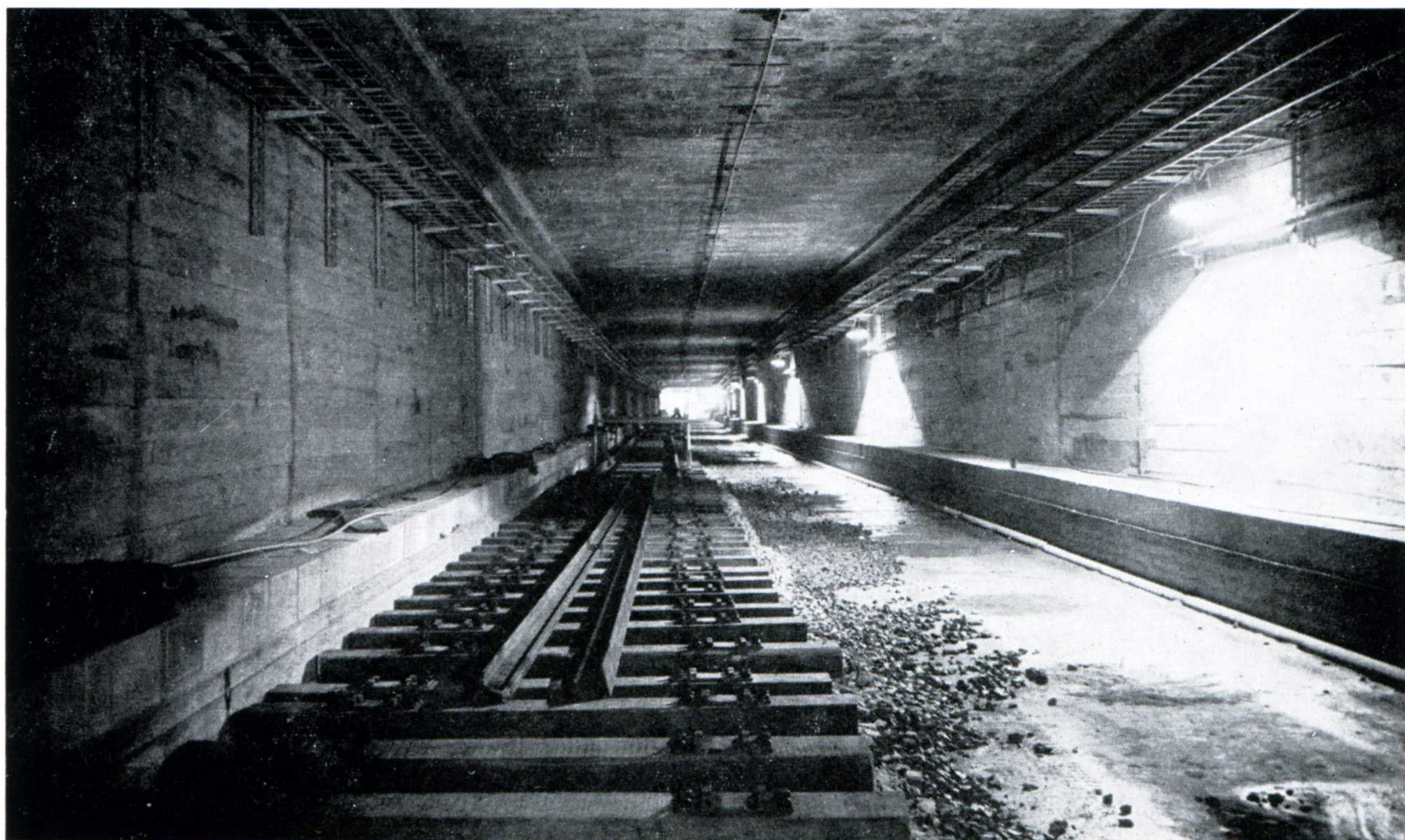
Voie en cours de pose dans un tunnel du métro de Bruxelles
