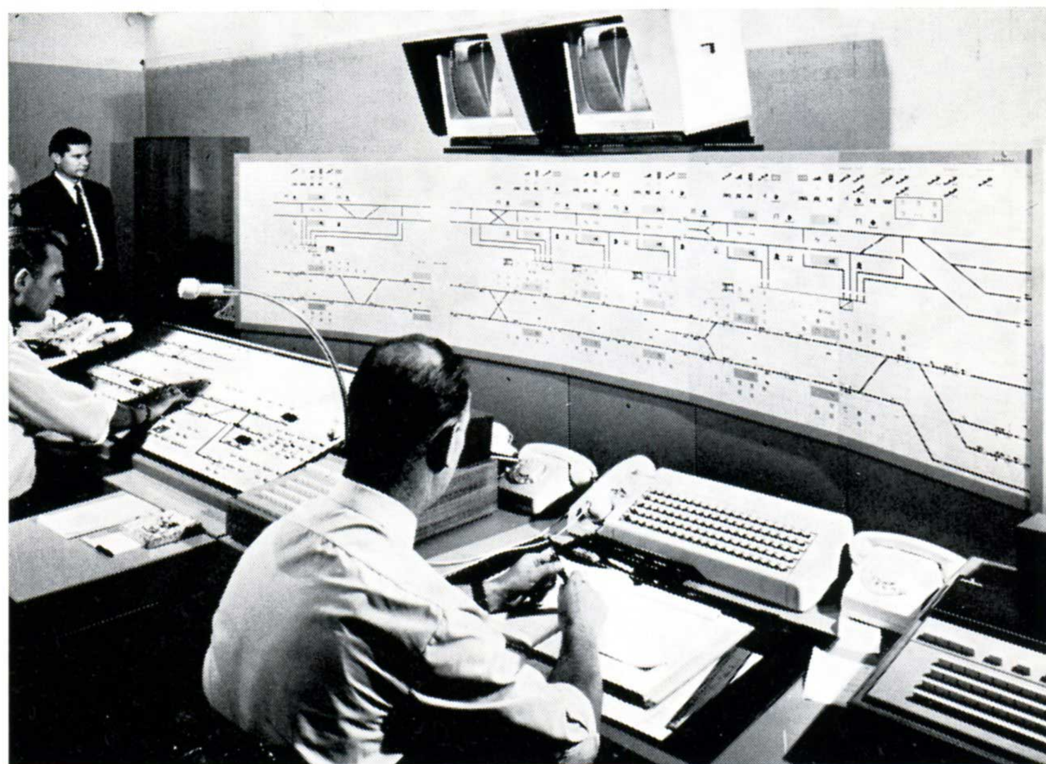
Vue partielle du poste central de commande du nouveau système de régulation du trafic (photo Siemens)
