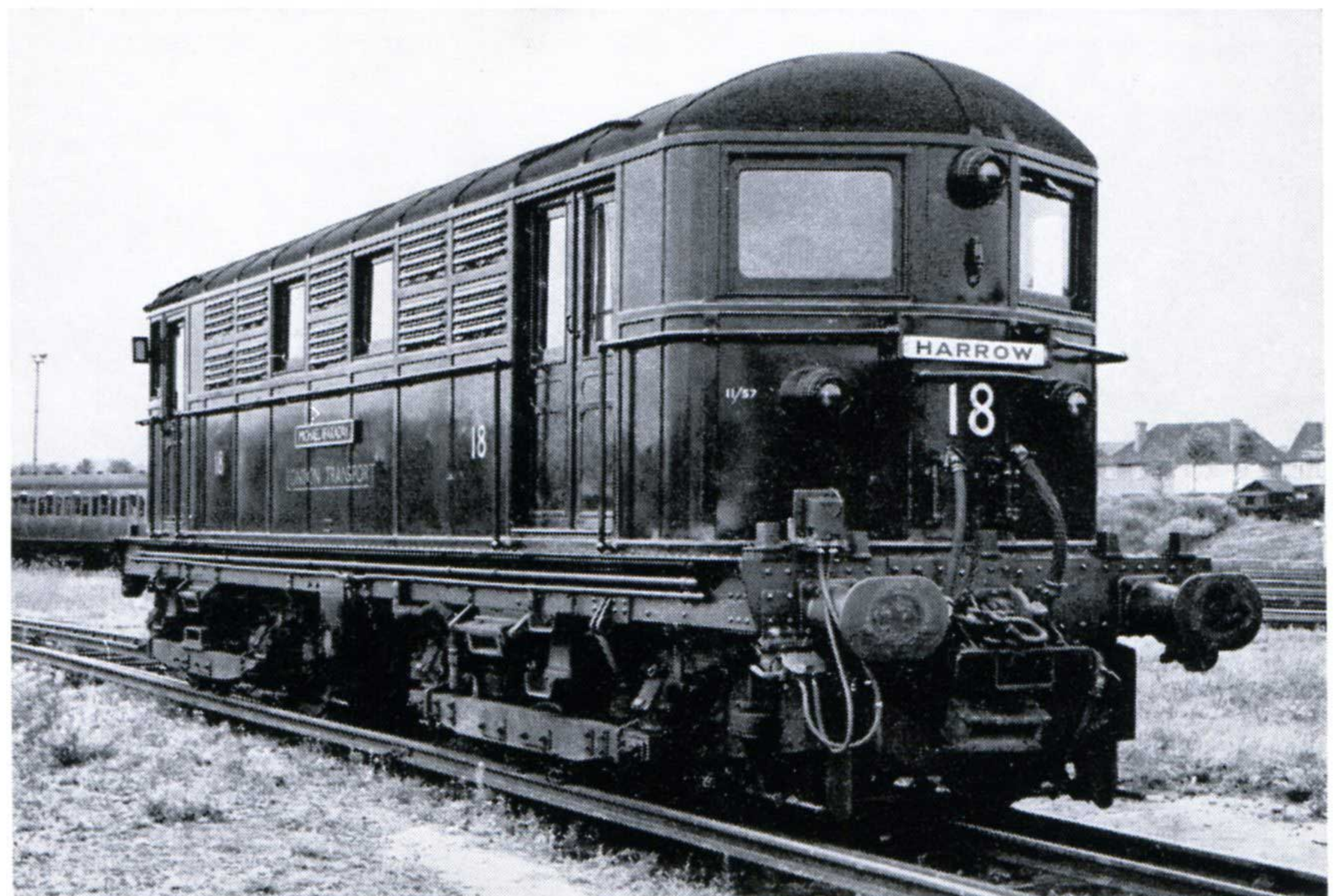
Locomotive électrique BB de 1200 CV (1922-23) ; suivant la tradition anglaise si sympathique, elle porte le nom de Michael Faraday. (photo London Transport Board)
