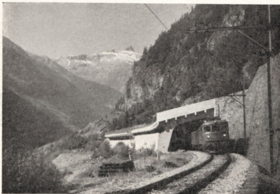
Galerie de protection contre les avalanches dans la vallée de la Lonza (Photo A. Steiner)
