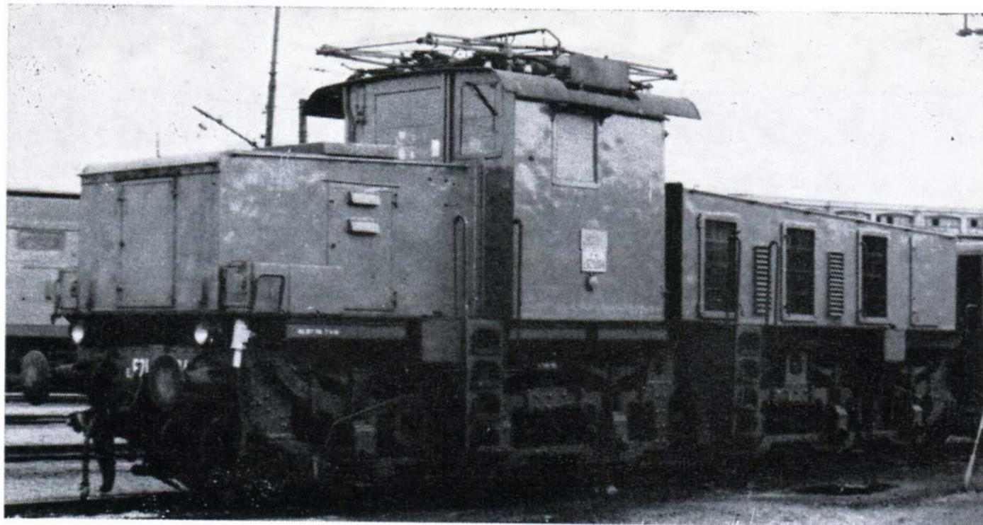
Locomotive de manœuvre Gr.E.621 type Co + Co à groupe métadyne 3 kV, anciennement Gr.E.620 du continu 650 V à 3ème rail.
