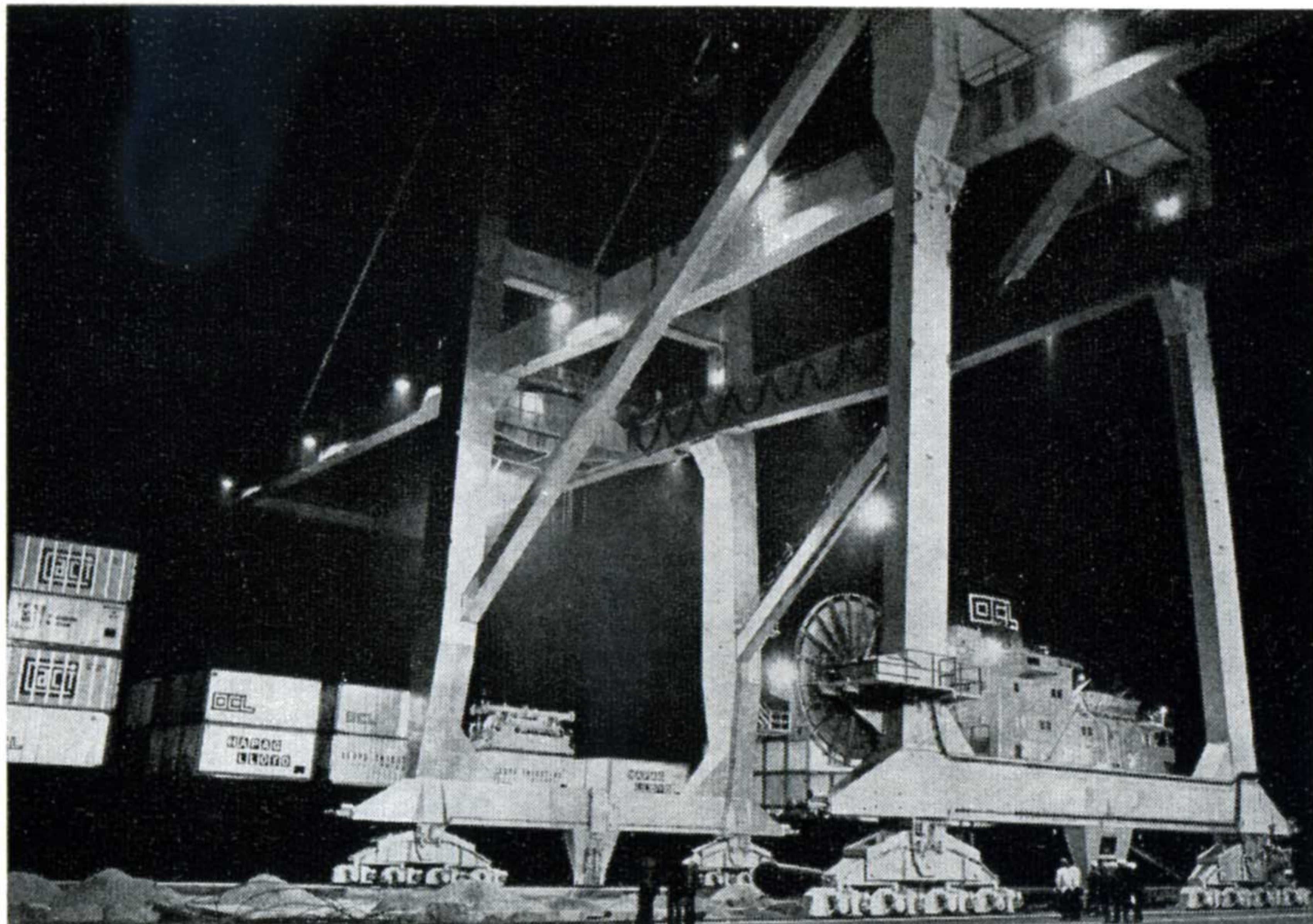
L'un des gigantesques portiques du nouvel ocean terminal de Zeebrugge.
