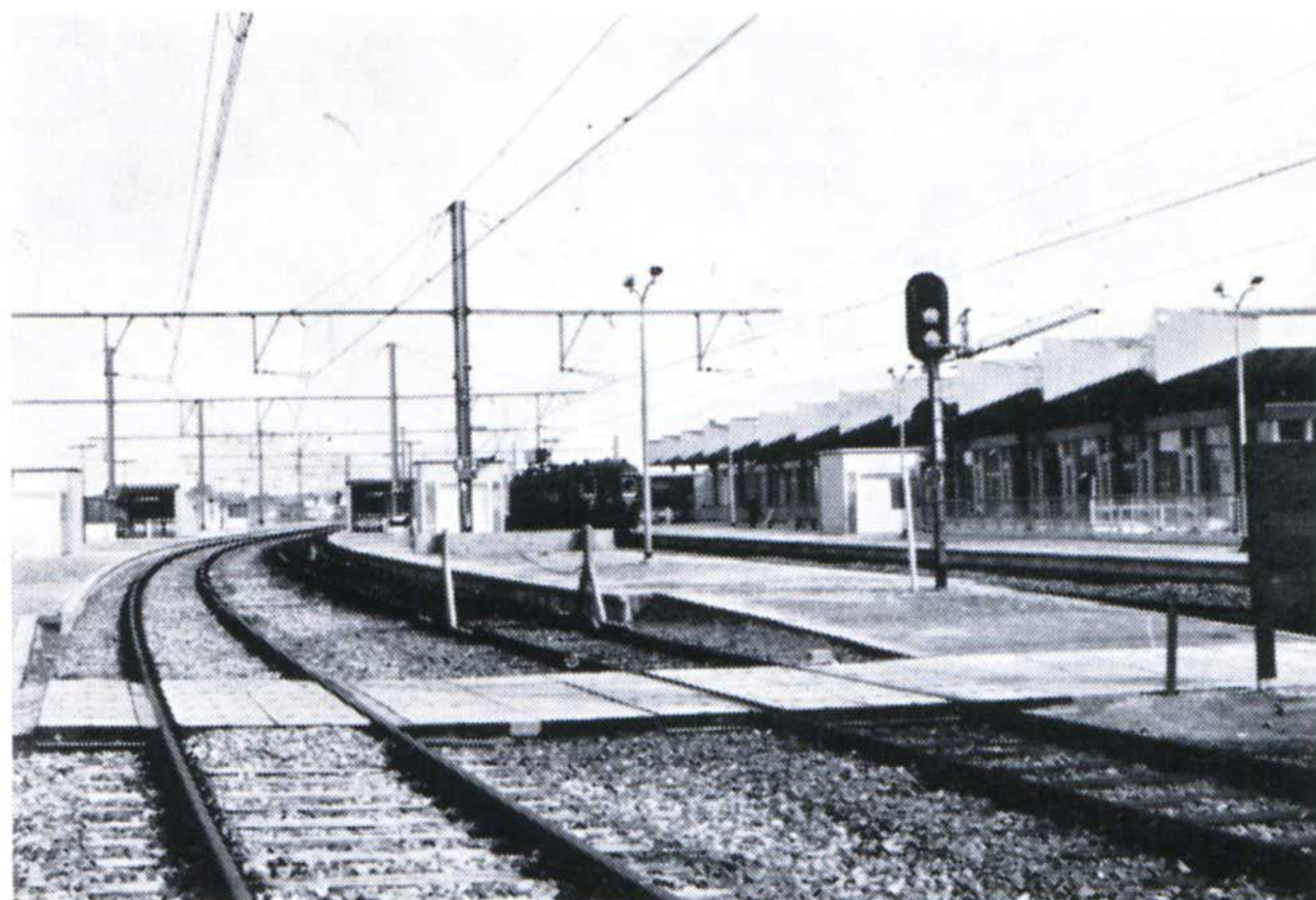
▼ Ci-dessous, à gauche, la gare de St. Nicolas, à droite, électrification en cours sur le viaduc de St. Nicolas, vers Gand (photos B. Dedoncker)
