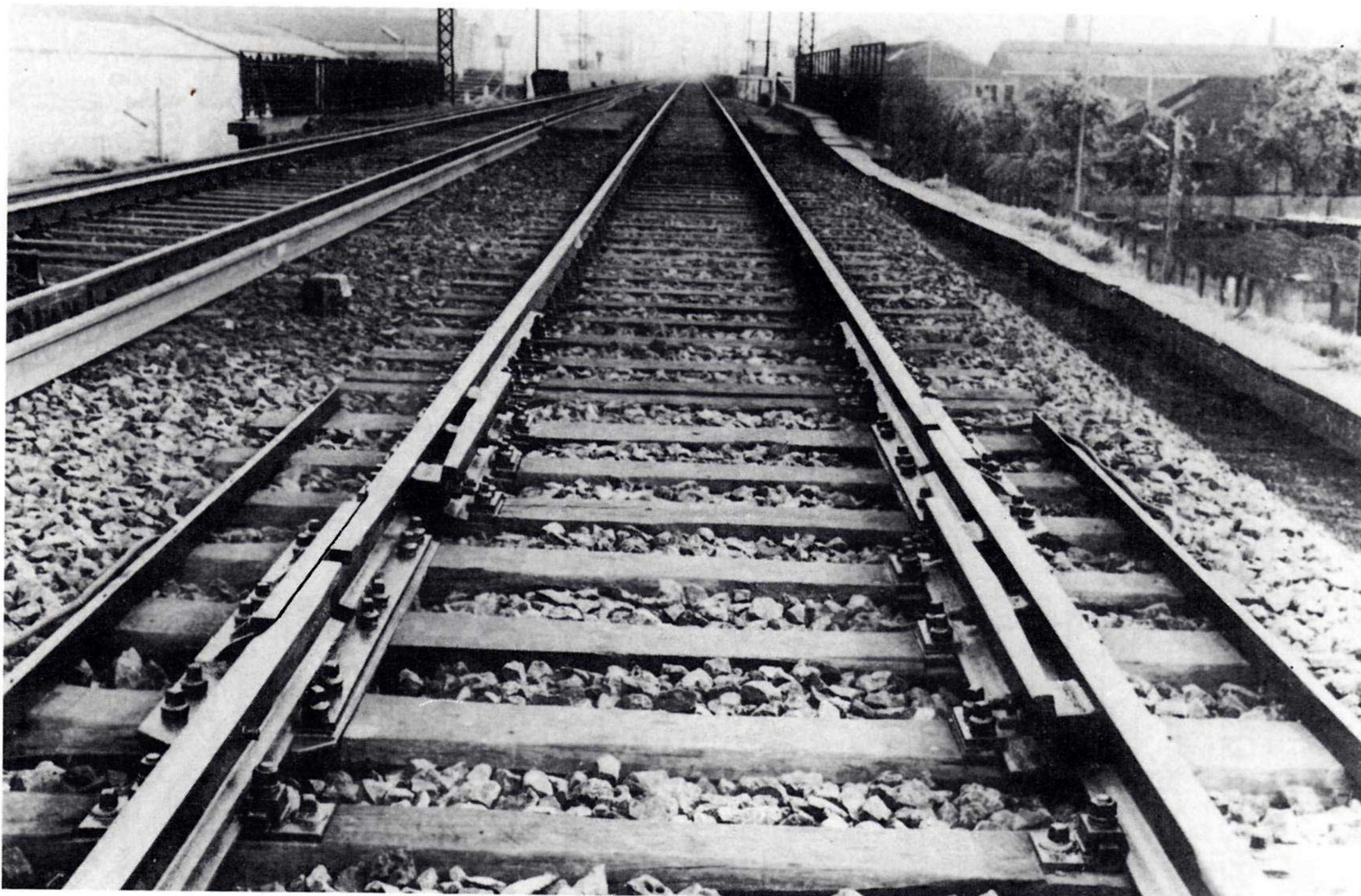
Ancien type d'appareil de dilatation : un "rail-pont" est fixé contre les deux têtes de rails, à l'extérieur de la voie et au droit du joint, de façon à permettre le passage des roues sans choc.
