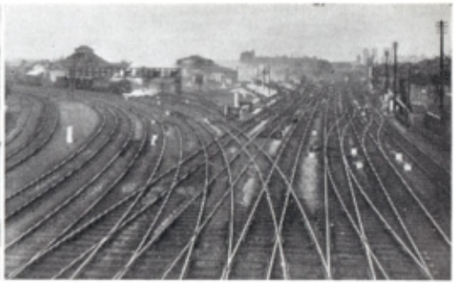
Les approches sud de la gare de York. (Photos British Railways)
