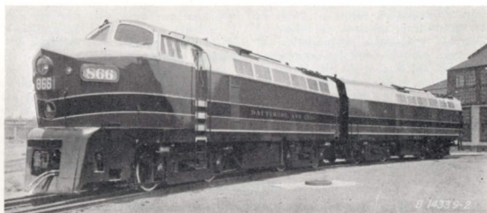
Deux unités de route à marchandises BLH, type RF-16, du BALTIMORE & OHIO, surnommées « Shark nose ».
