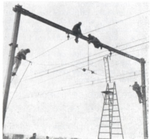
Fig. 27 — Placement du câble transversal.
