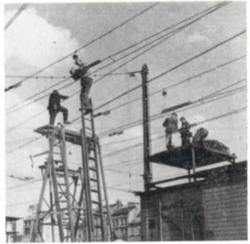
Fig. 18 — Placement d'isolateurs de section type S.N.C.B.
