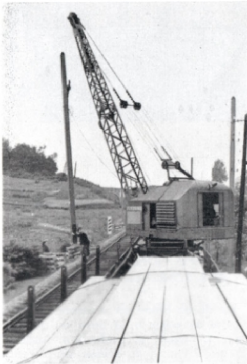
Fig. 29 — Ci-dessous : levage d'une console simple.
