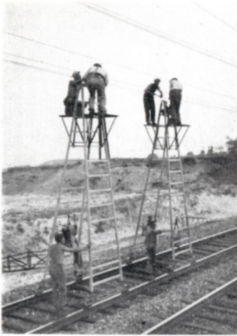
Fig. 32 — Pendulage de la caténaire.
