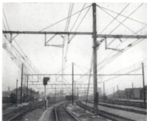
Fig. 8 — Portique de gare à Charleroi.
