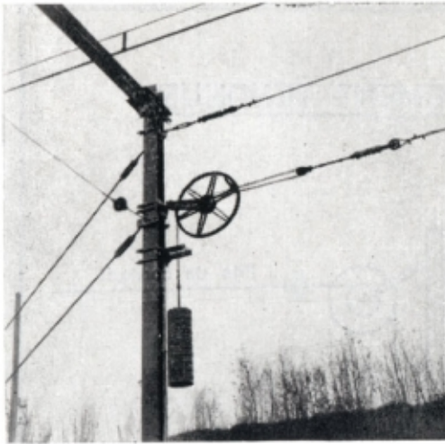
Fig. 14 — Appareil tendeur
