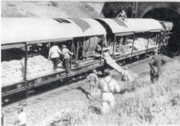
Fig. 26 — Train de bétonnage des fondations.
