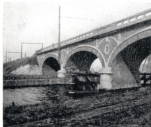
Fig. 9 — Pont sur l'Escaut équipé de poteaux à console double.
