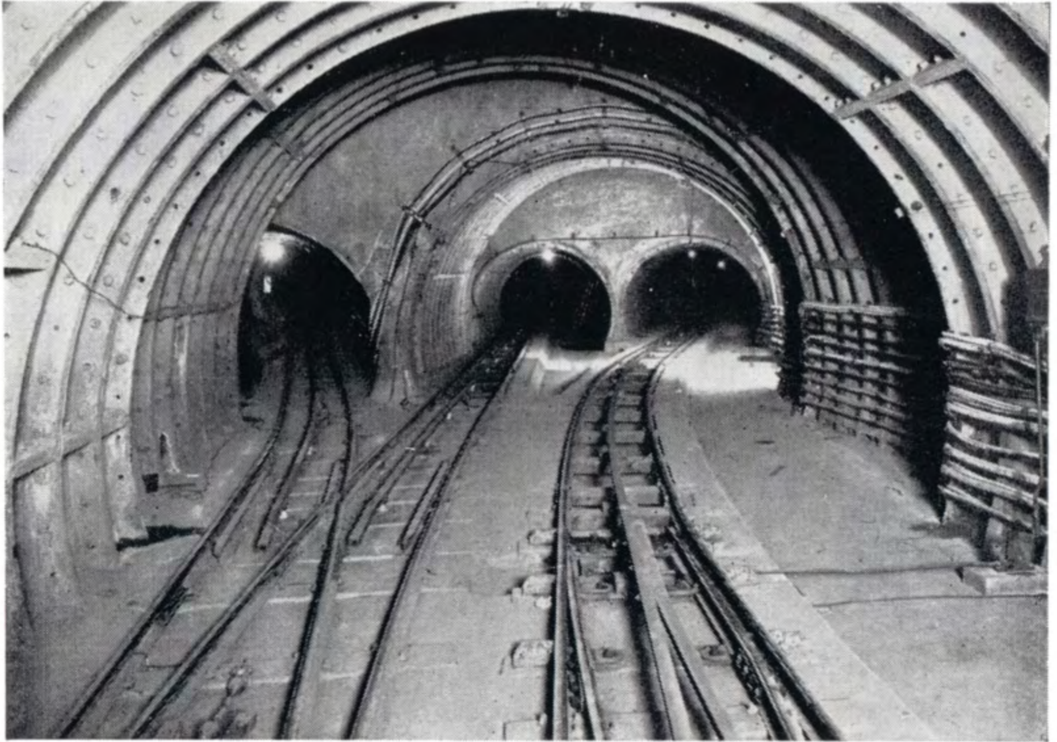
Vue caractéristique du tunnel.
