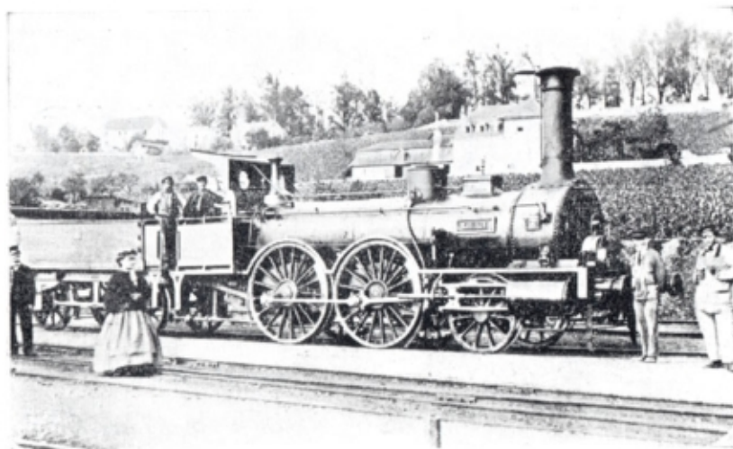
La locomotive « Chillon » du type 2/3, utilisée au début de l'exploitation de l'O. S.
