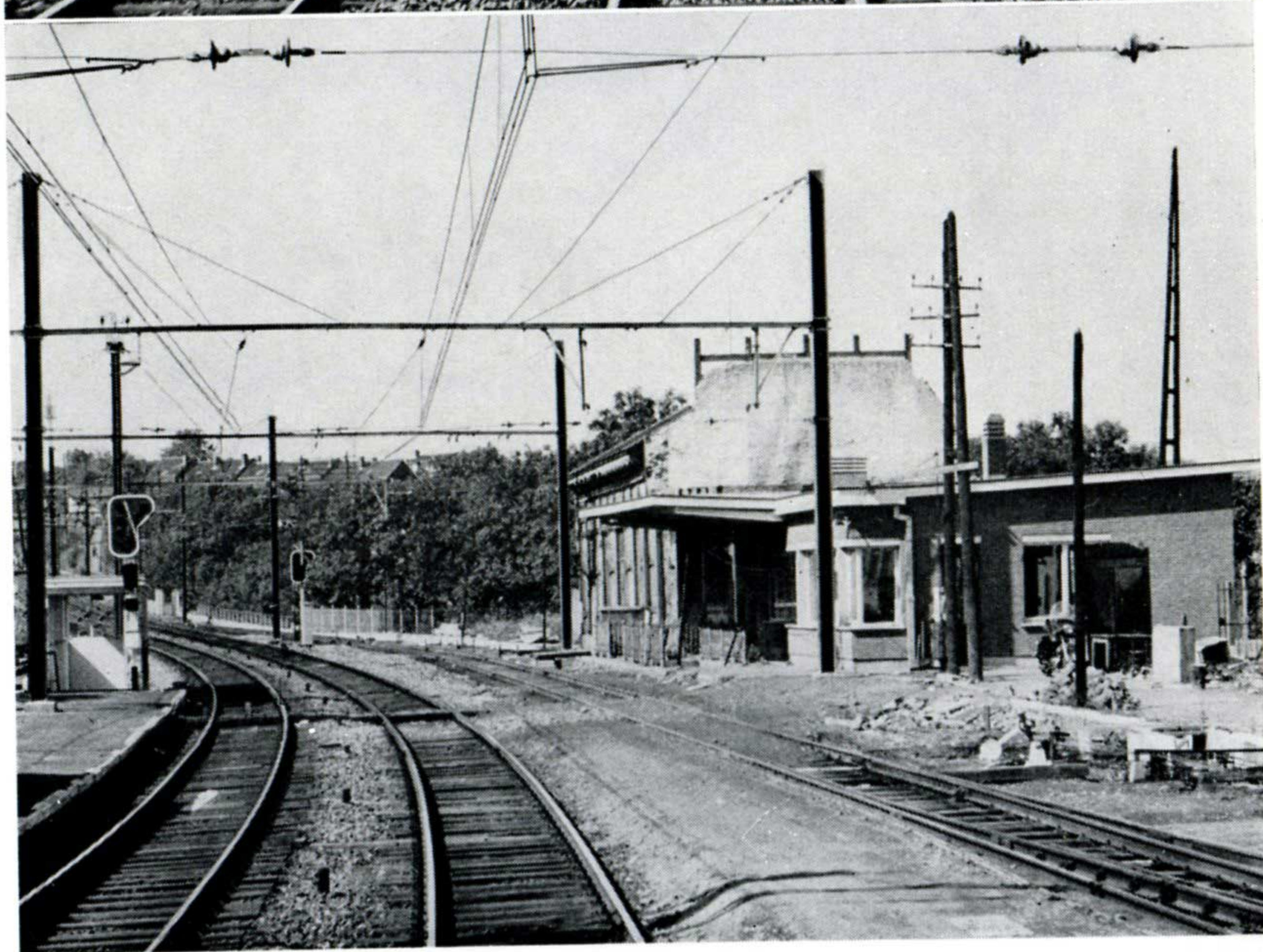
De haut en bas : pleine voie en Hesbaye et nouvelle gare de Liège Haut-Pré en construction. (Photos S.N.C.B.).
