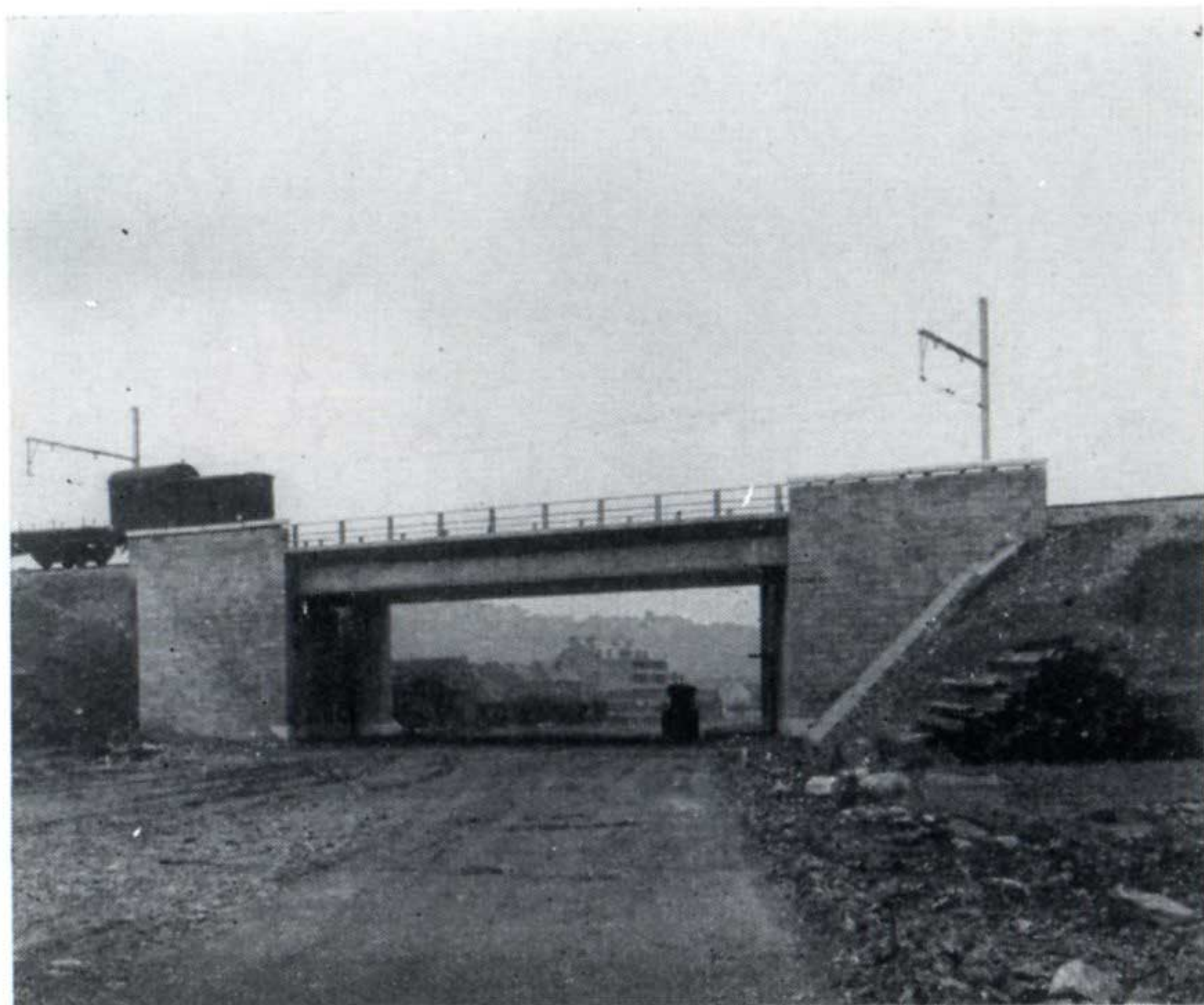
Photo 11. — Jambes (Km. 63.130). Nouveau pont au-dessus de la nouvelle route vers Liège et Marche.
