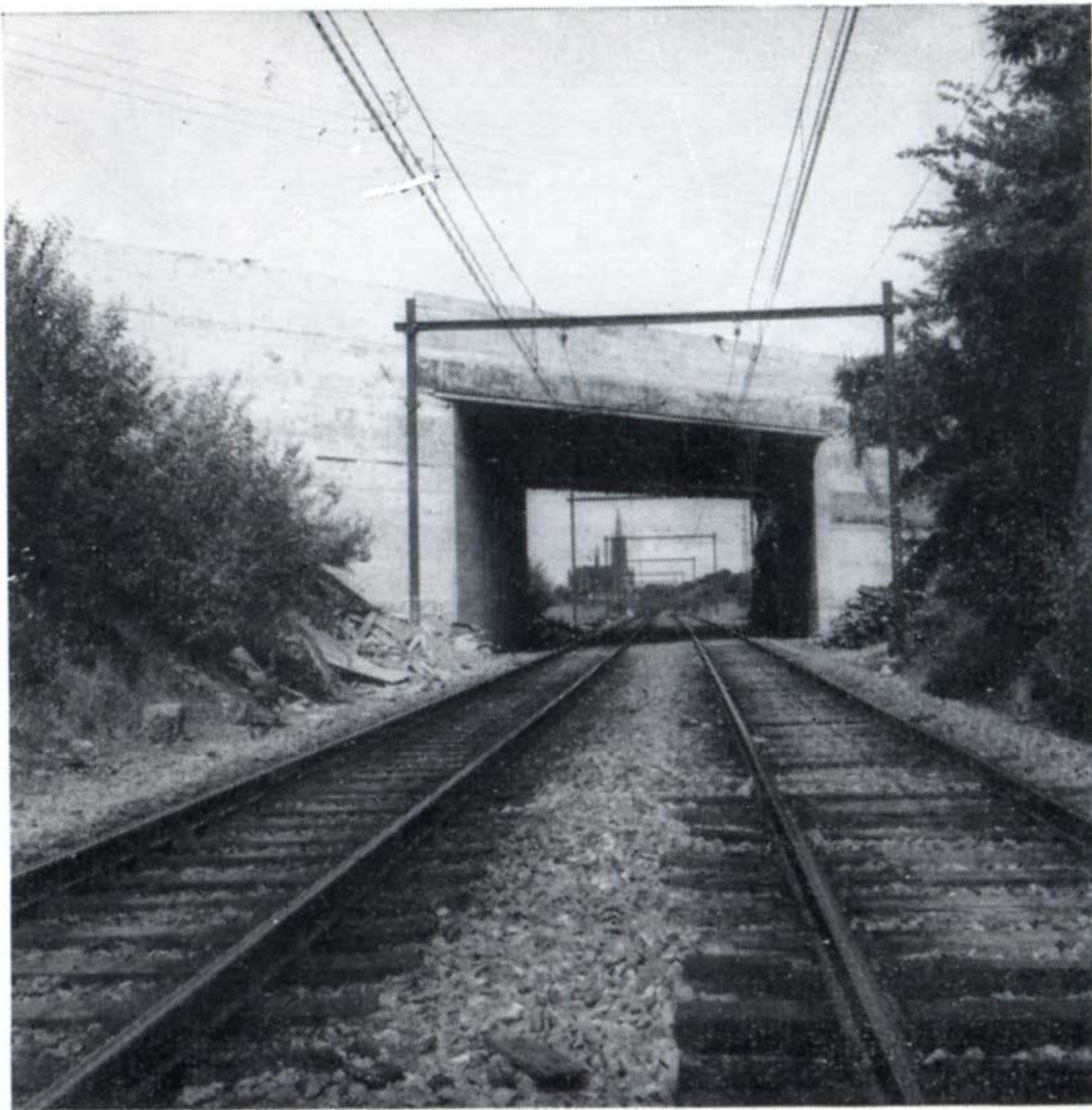
Photo 8. — Pont de Longwy (Km. 199.277) à Arlon. L'ouvrage est achevé. La toilette extérieure des parements reste à exécuter.
