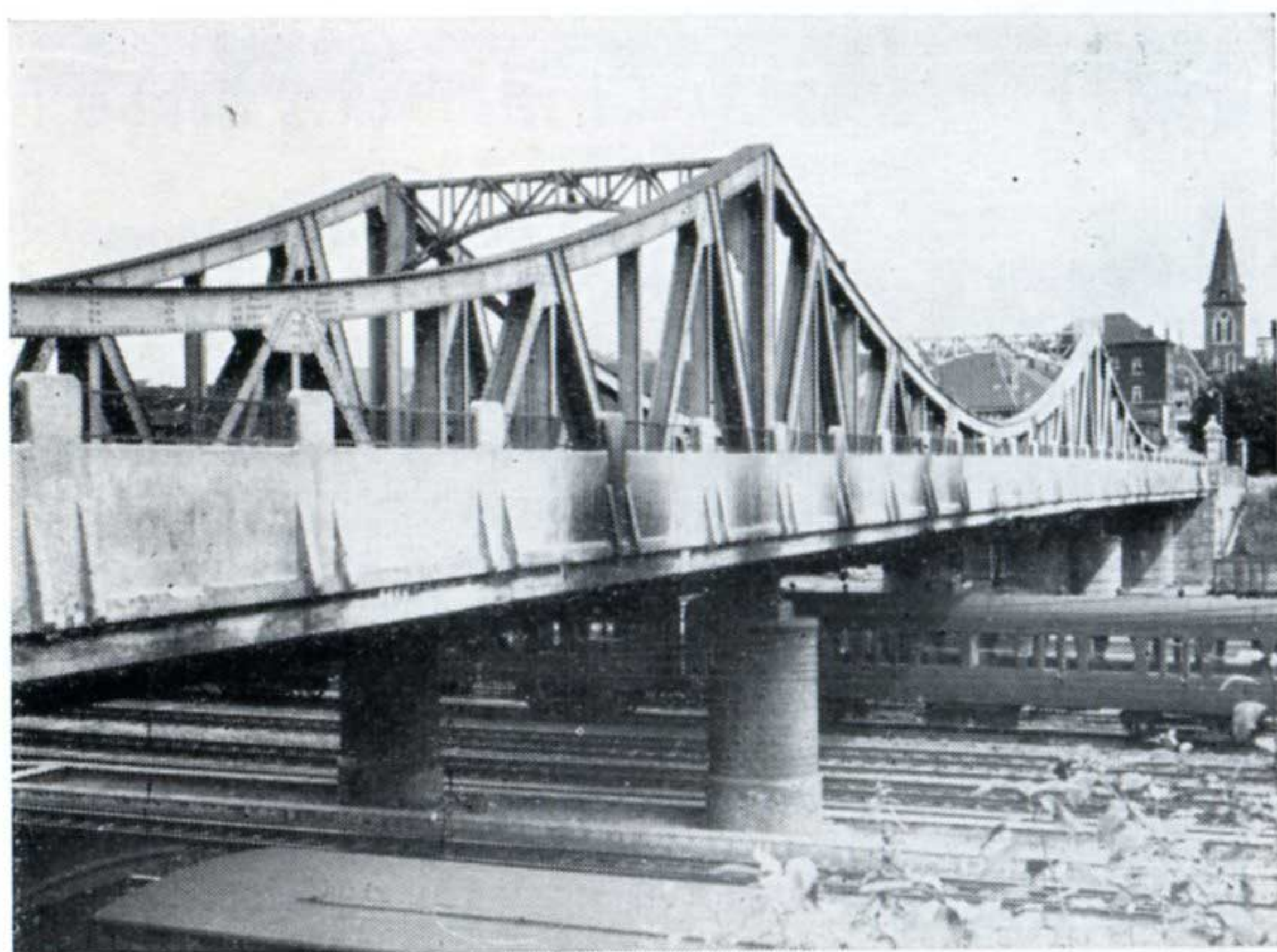
Photo 3. — Namur (Km. 61.863). Nouveau garde-corps en béton, surmonté d'un treillis métallique.
