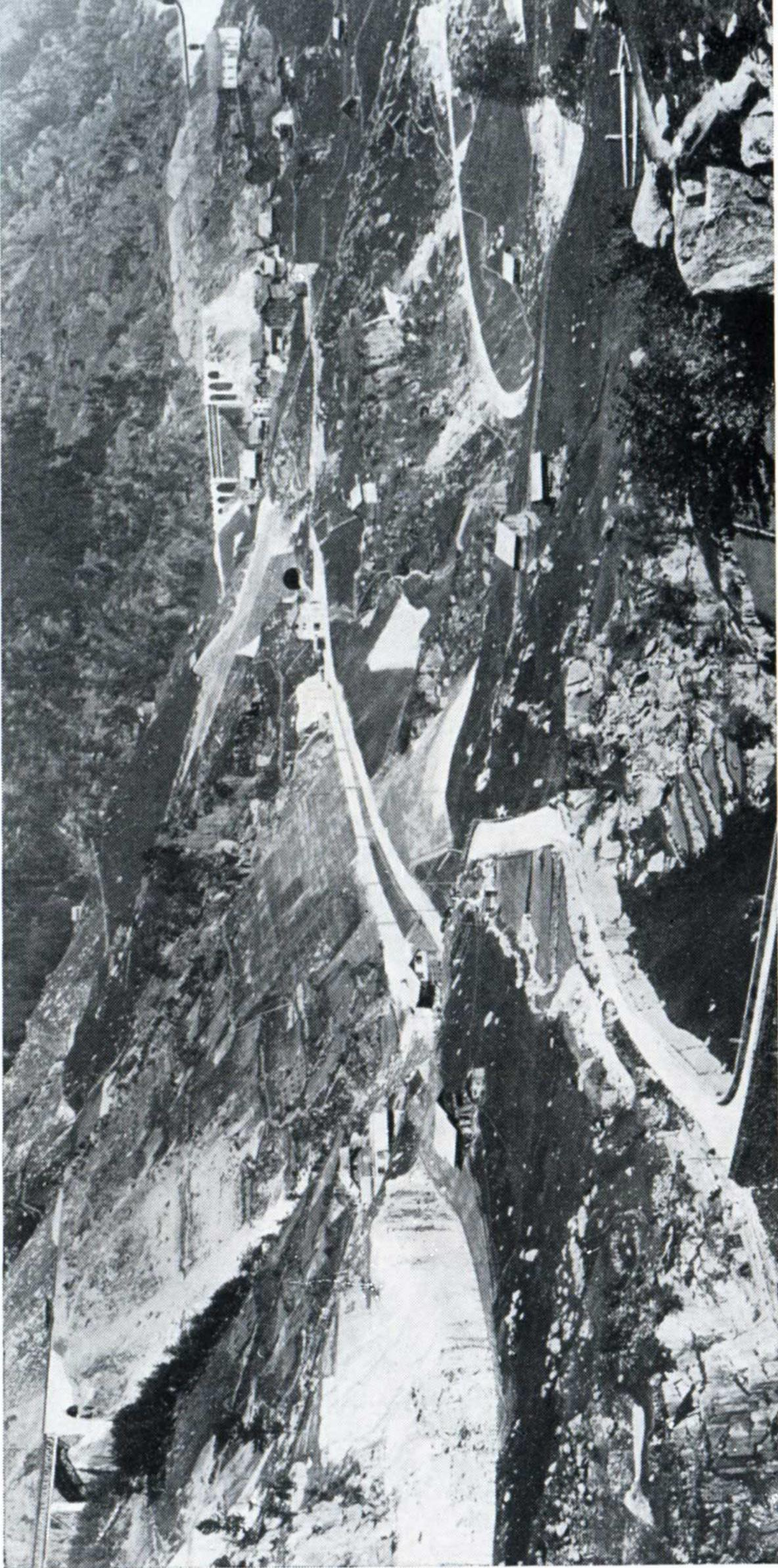
Etablissement de la ligne à Wassen ; on remarquera l'ampleur des chantiers qui, pour l'époque, étaient vraiment colossaux ; on se souviendra en effet qu'il n'y avait alors ni grappins, ni draglines et encore moins des bulldozers ; tout se faisait à l'explosif et à bras d'hommes !
