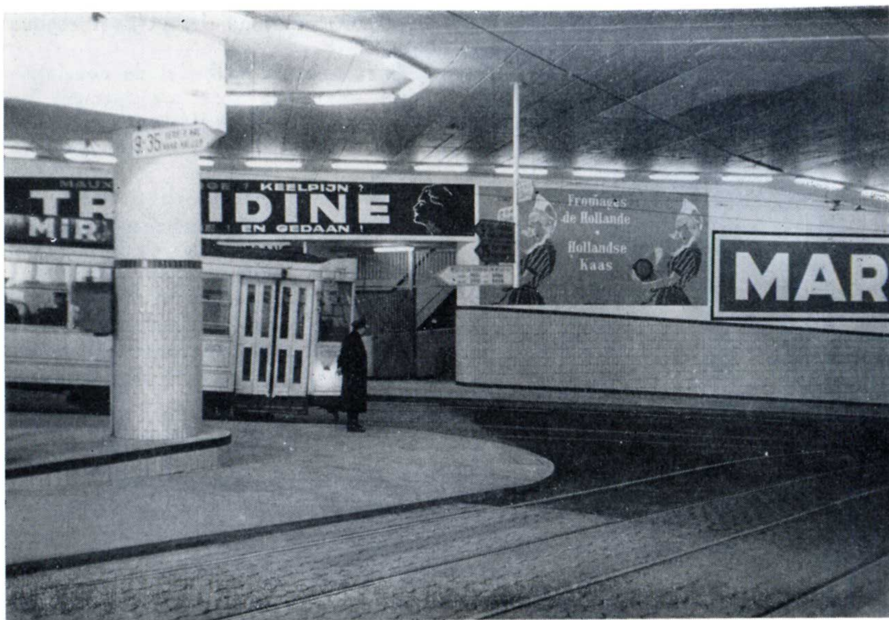
Photo 3 : vue du raccordement des stations « Lemonnier » et « Poincaré ».
