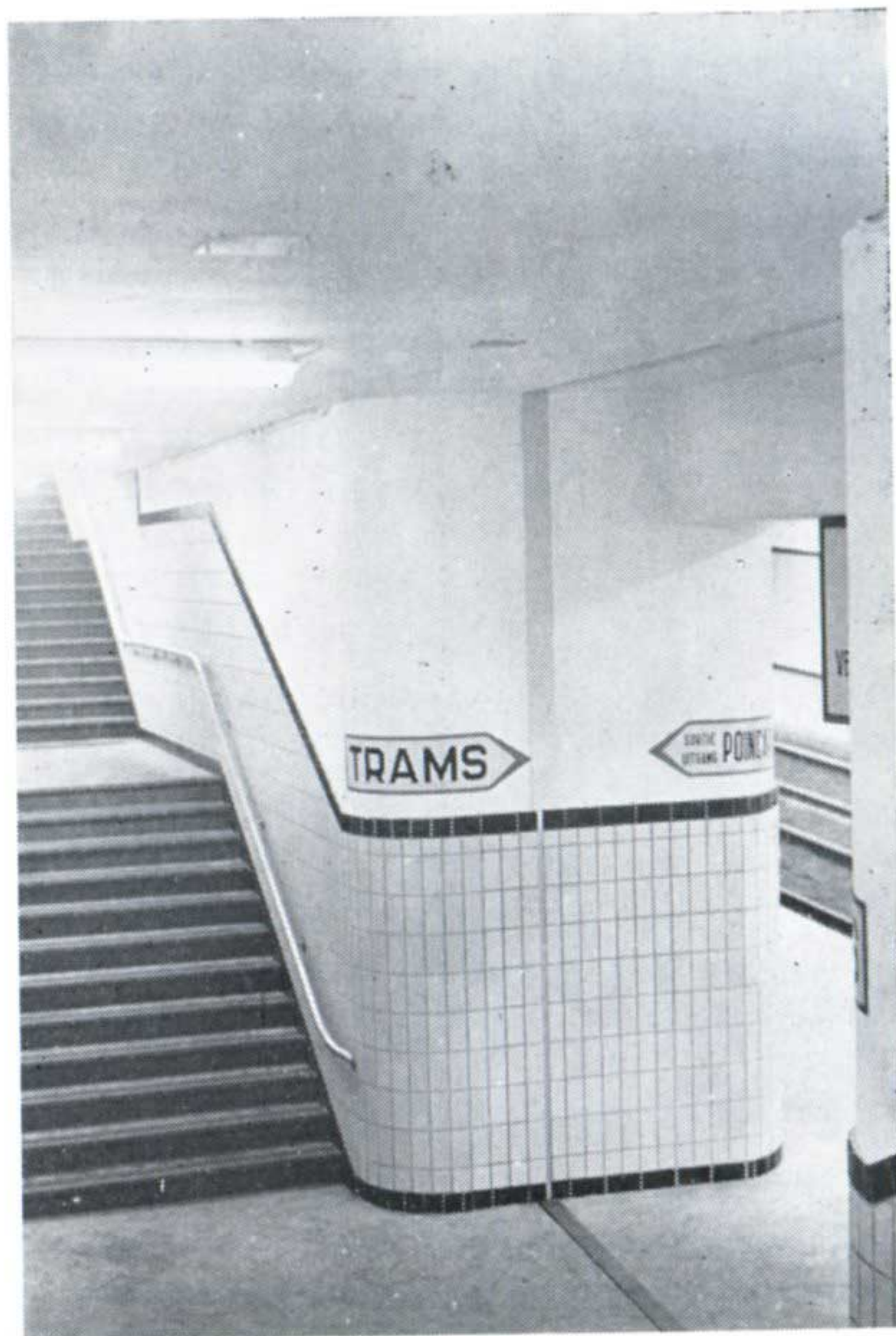
Photo 1 : sortie de la station Poincaré et sa signalisation ; on remarque un joint de dilatation au centre de la photo.
