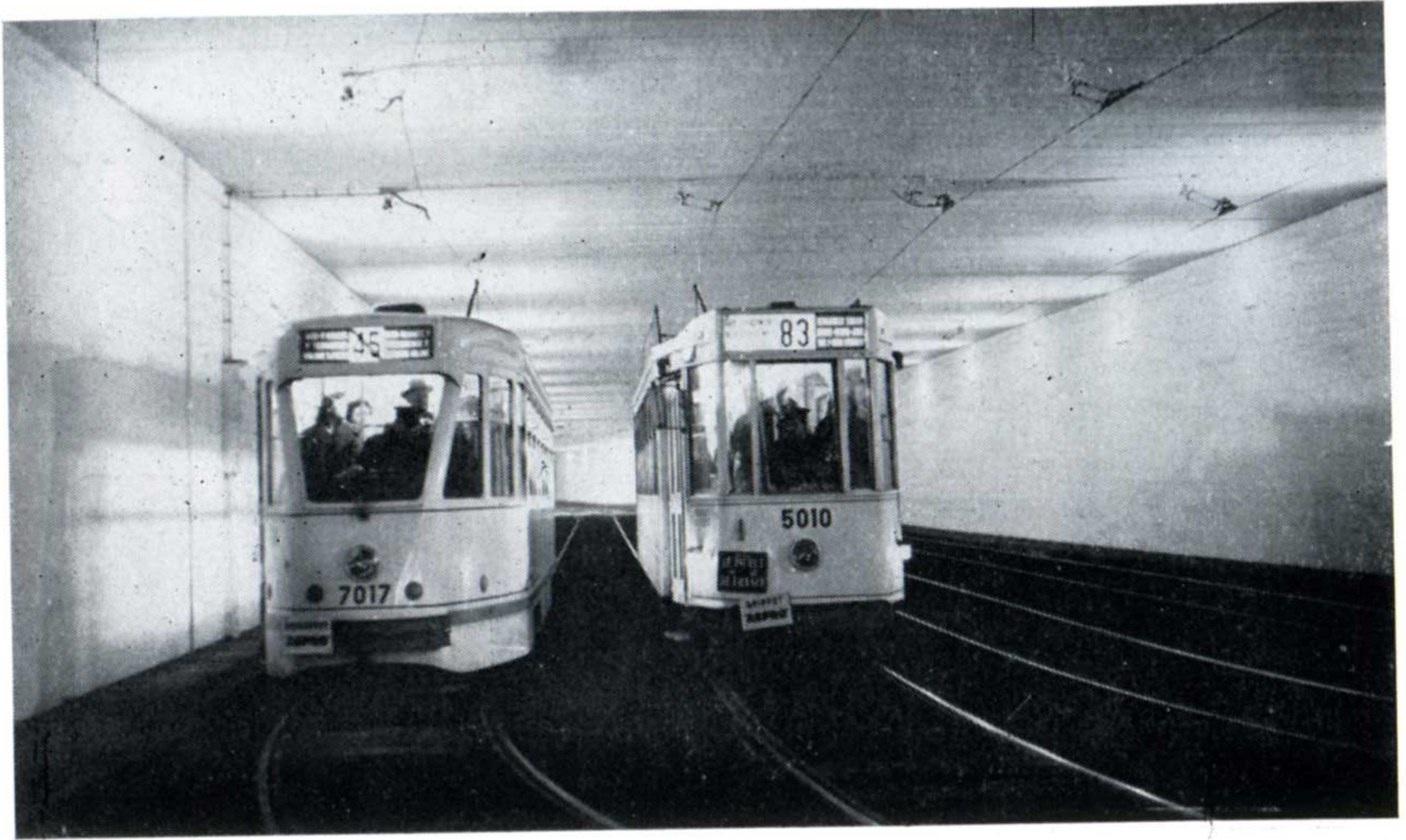
Photo 12 : deux convois se présentent ensemble pour emprunter la rampe « Midi » ; en vertu de la signalisation au sol (simple convention) c'est au 83 de passer le premier. (Photo H.-F. Guillaume)
