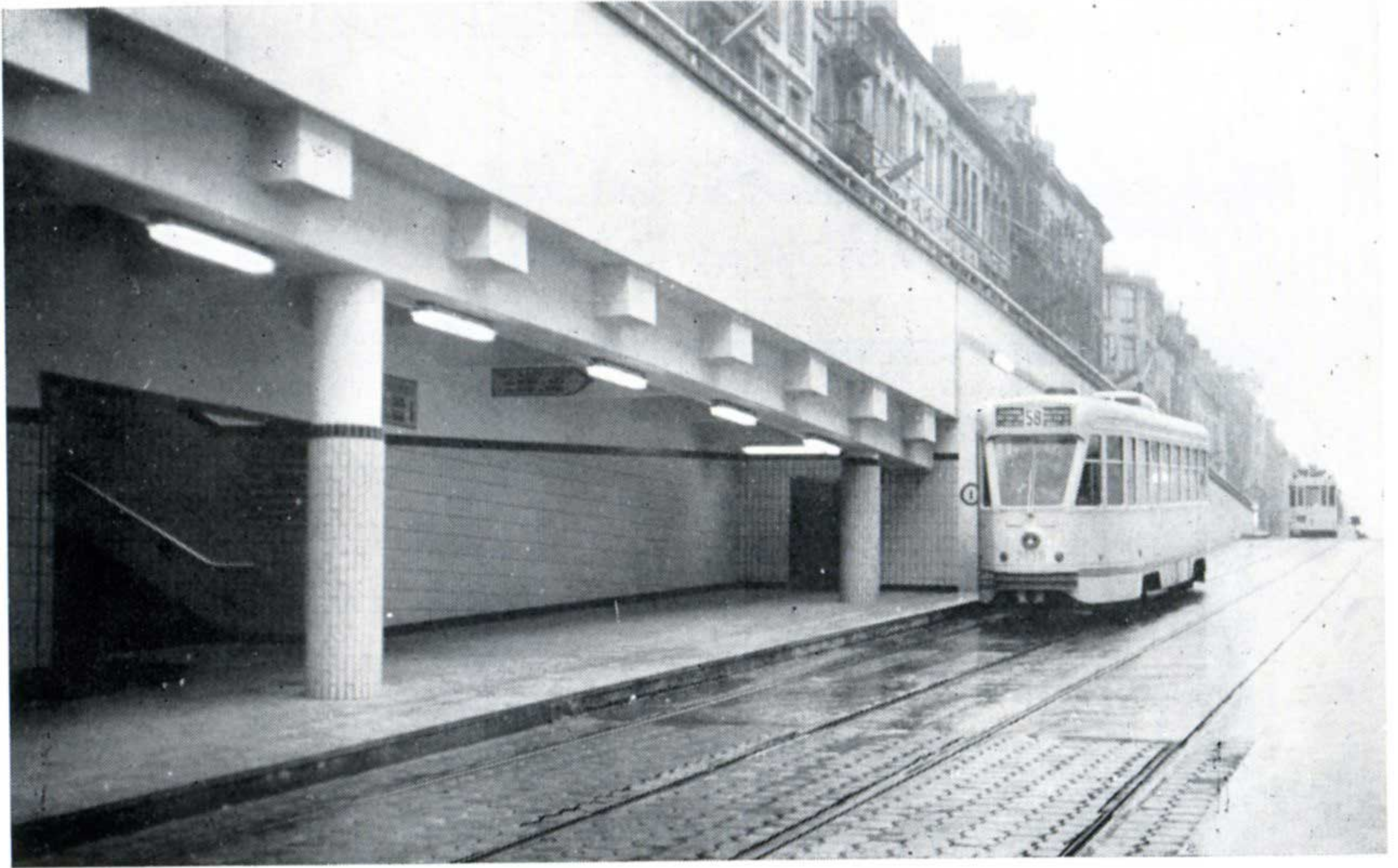
Photo 6 : la rampe Lemonnier vue vers le centre de la ville.
