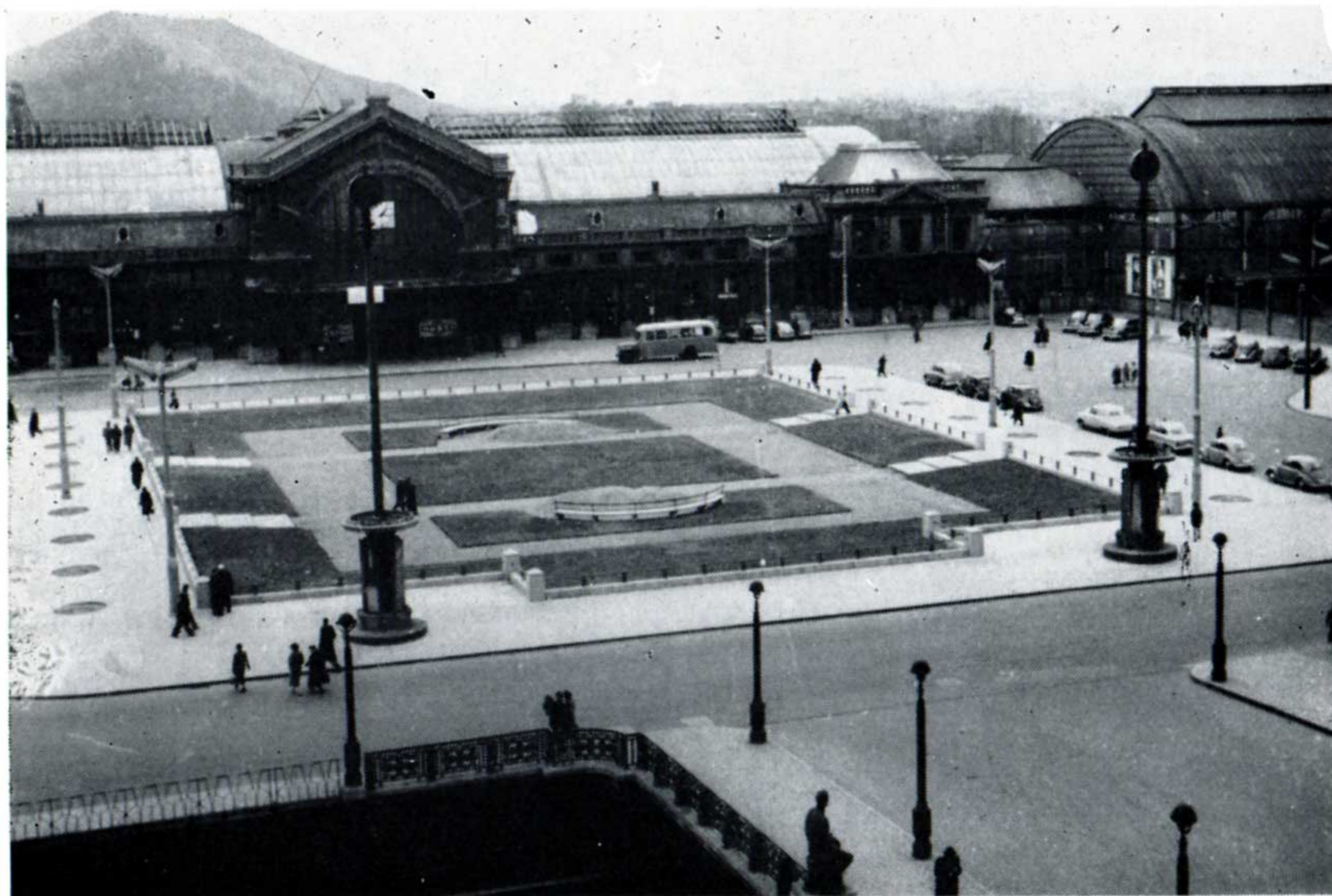
Fig. 2 — Vue, côté ville, de Charleroi-Sud fin 1957.
