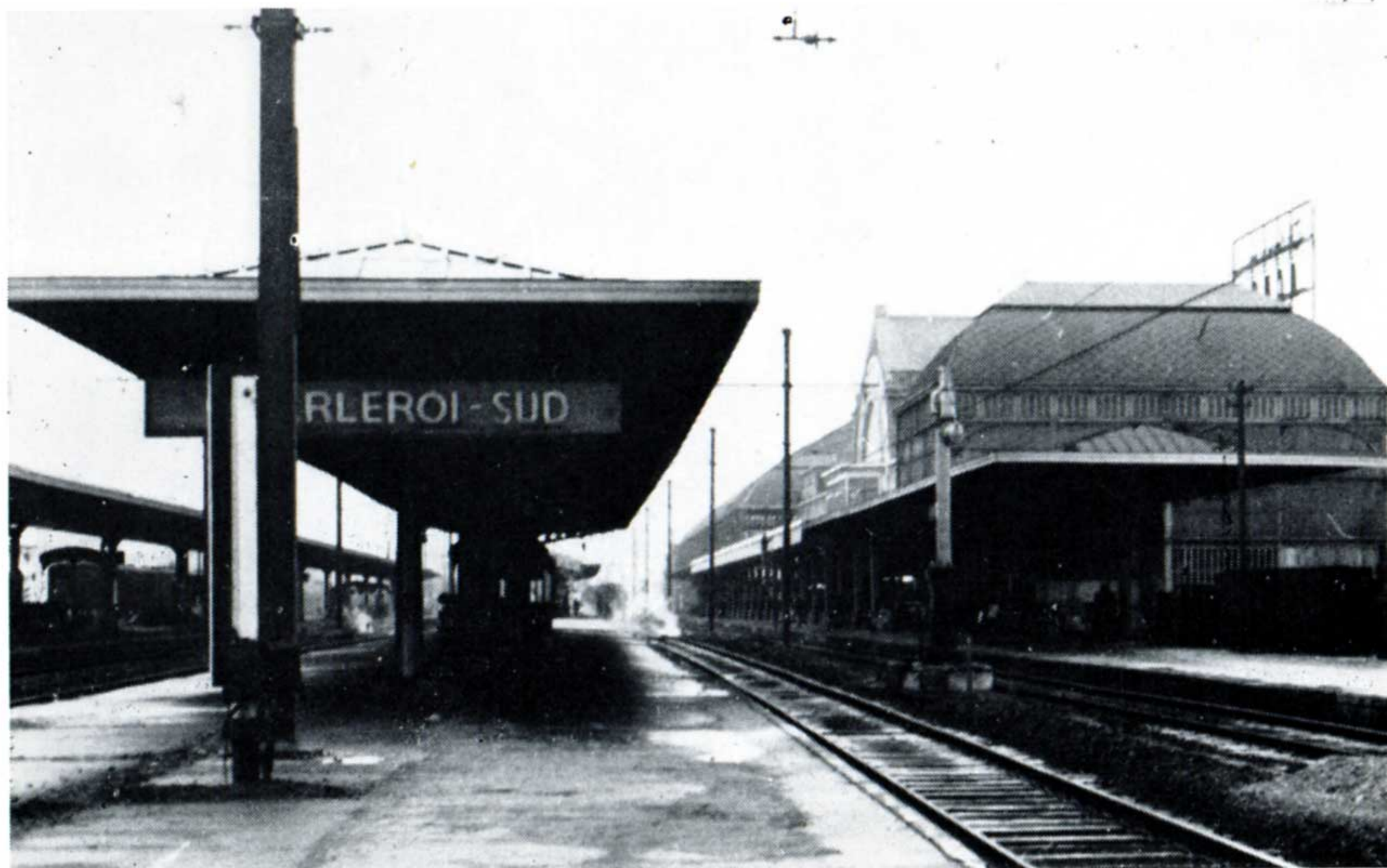
Fig. 6. — Charleroi-Sud aujourd'hui. — L'abri du quai n° 1 est achevé et les poteaux de caténares implantés entre les voies 1 et 2, et 3 et 4. (Photo de l'auteur)
