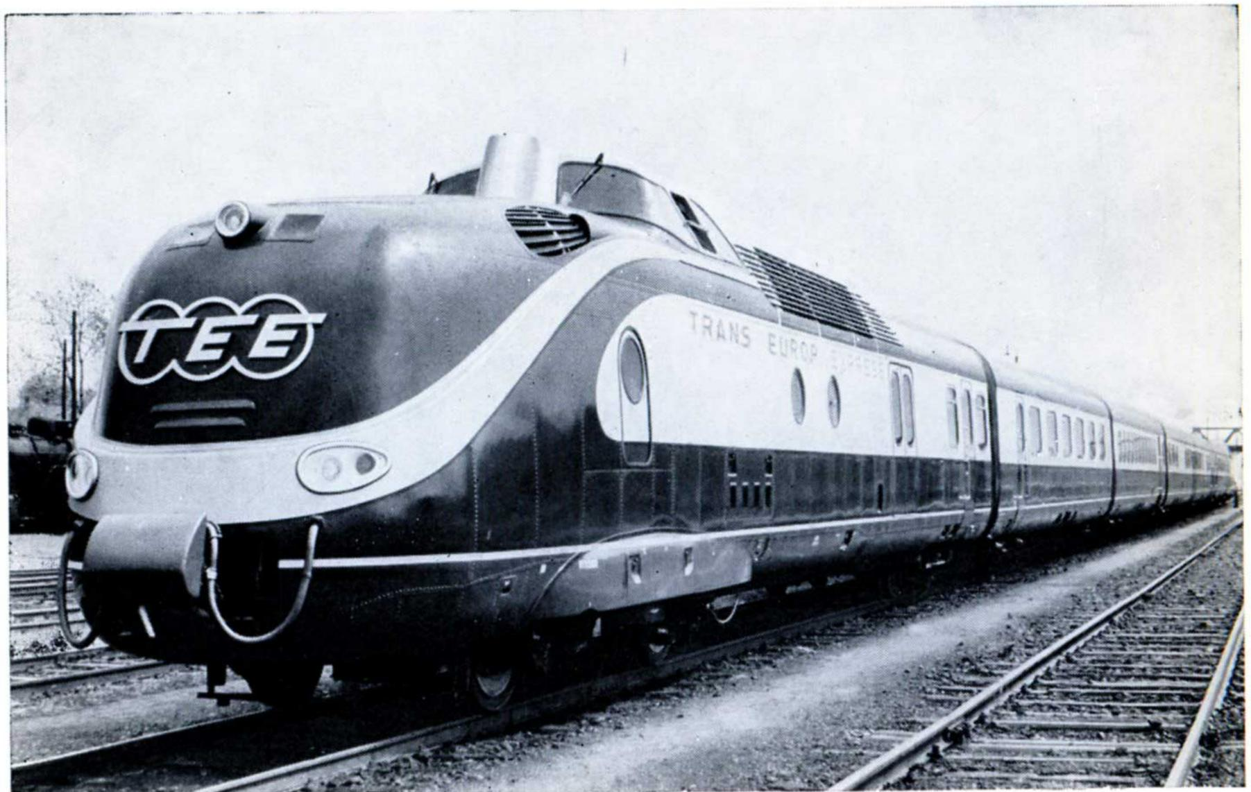
La rame quadruple T.E.E. des CFF/NS : vue de la locomotive ou plutôt de l'électromoteur.
