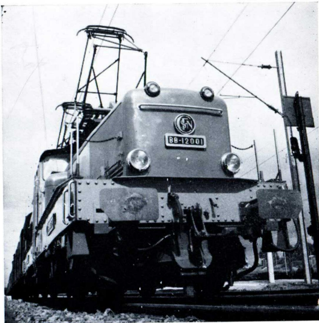
tements : un compartiment central qui contient l'appareillage et les machines auxiliaires, et deux cabines de conduite qui l'encadrent.
