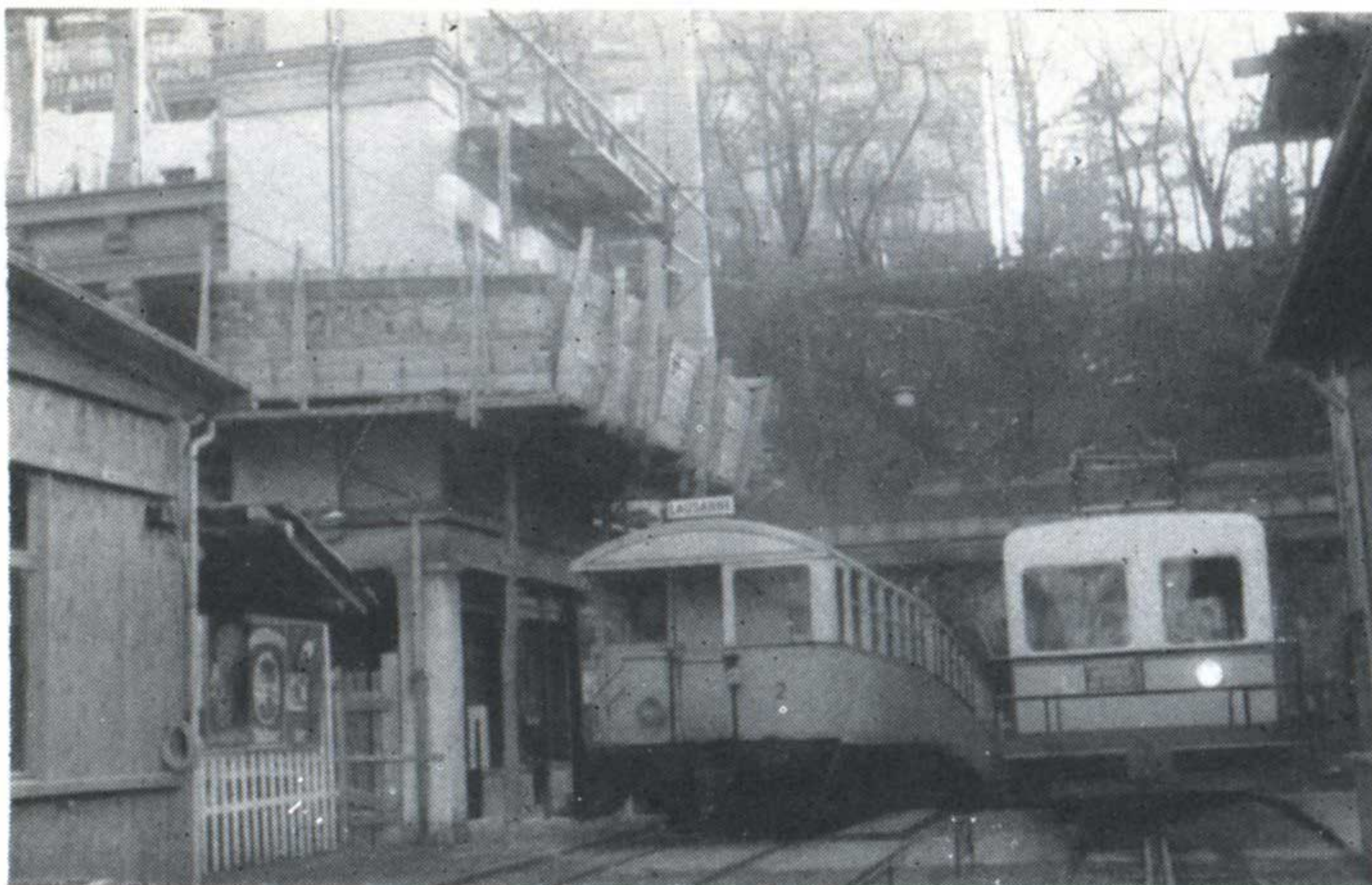
En gare du Flon, à gauche, l'ancien bâtiment en cours de démolition ; au centre, rame du LO et, à droite, automotrice Beh 2/2 du LG.
