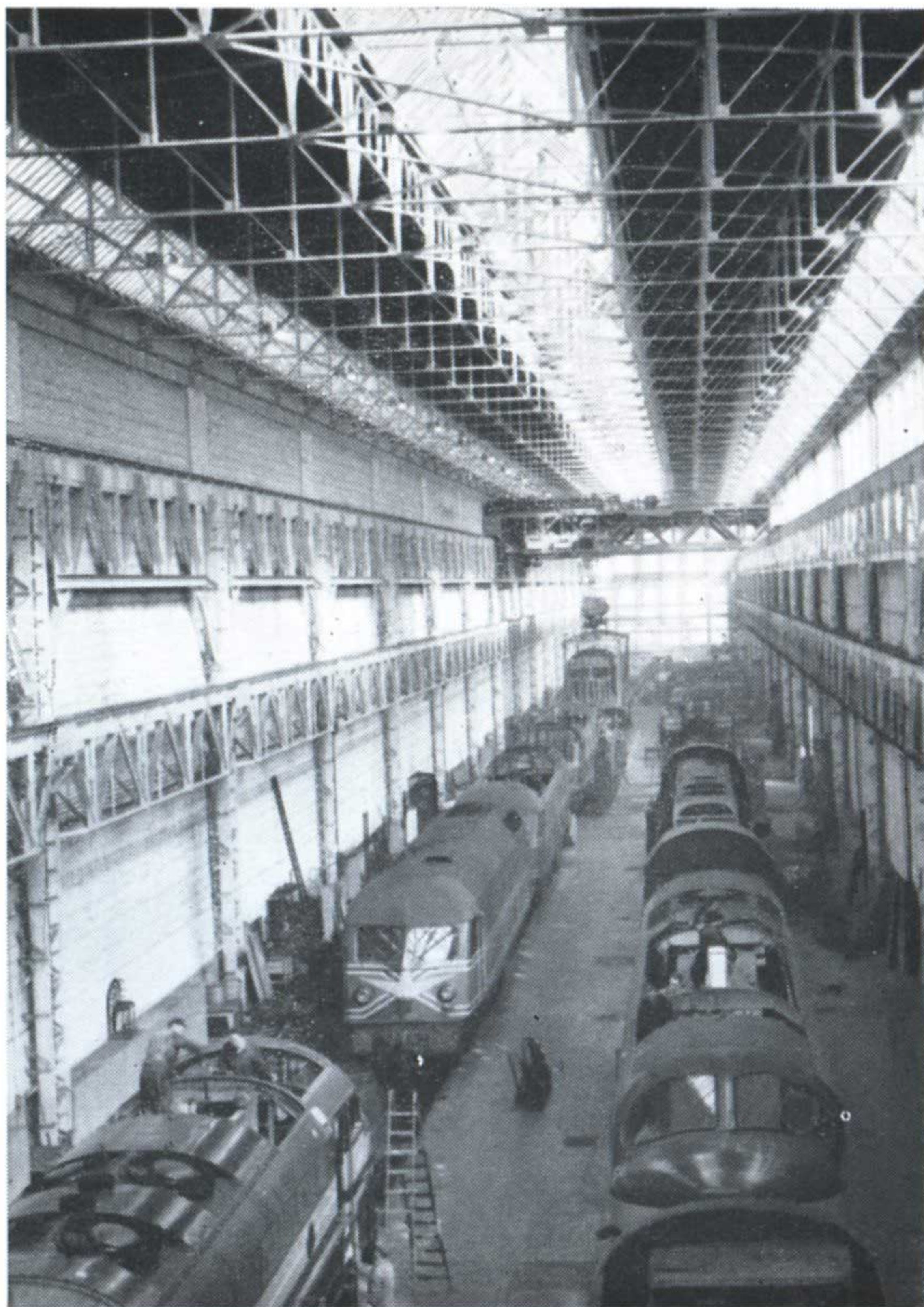
Atelier Central de Salzinnes. Voici le hall de grande ré- vision des locomotives Diesel de la S.N.C.B.
