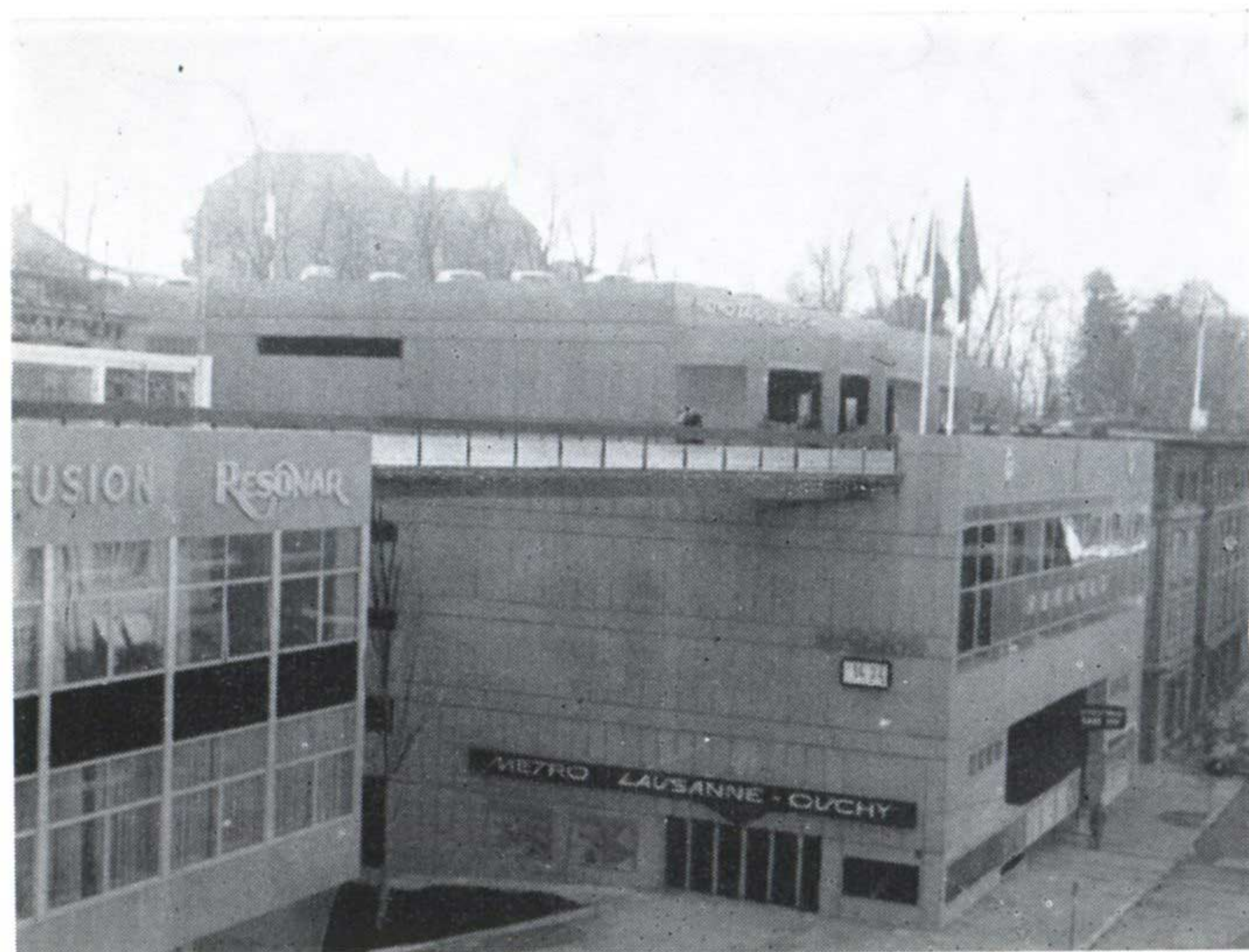
Vue générale de la nouvelle gare du Flon LO - LG, vue du Grand Pont.
