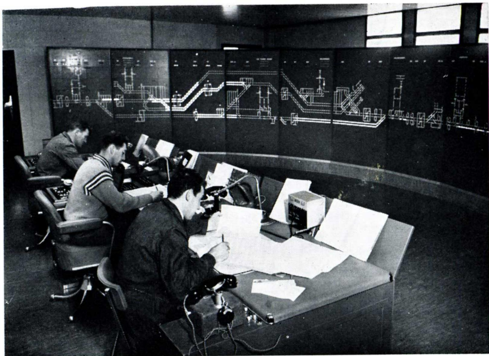
Les huit sous-stations de traction de l'électrification Nord-Paris sont contrôlées par deux postes de commande centralisée situés à Paris et à Douai. (Photo L. Viguier - S.N.C.F.)
