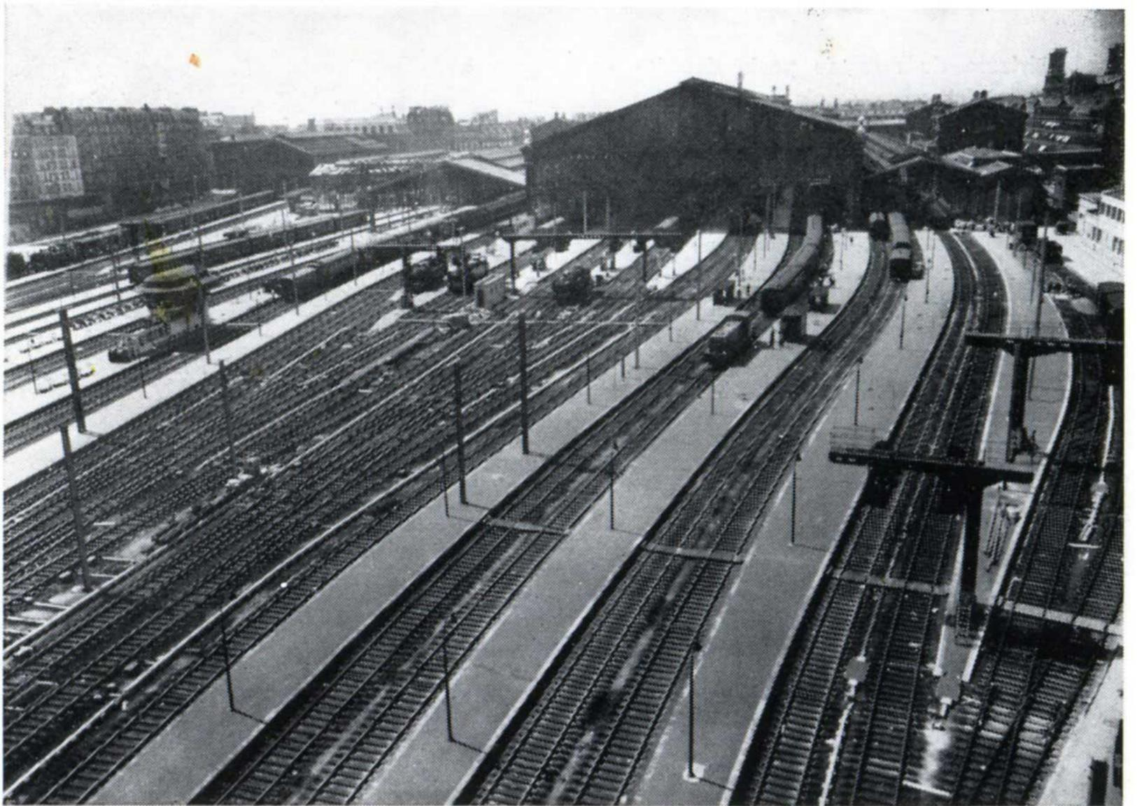
La gare de Paris-Nord, avant et après l'électrification. On remarque l'allongement des quais et la simplification des voies dont le nombre d'appareils a été ramené de 183 à 103 ; ces importants travaux ont été exécutés dans des conditions fort délicates, le trafic de Paris-Nord ne pouvant être interrompu, tout spécialement en ce qui concerne les pointes des lignes de banlieue. (Photos S.N.C.F.)
