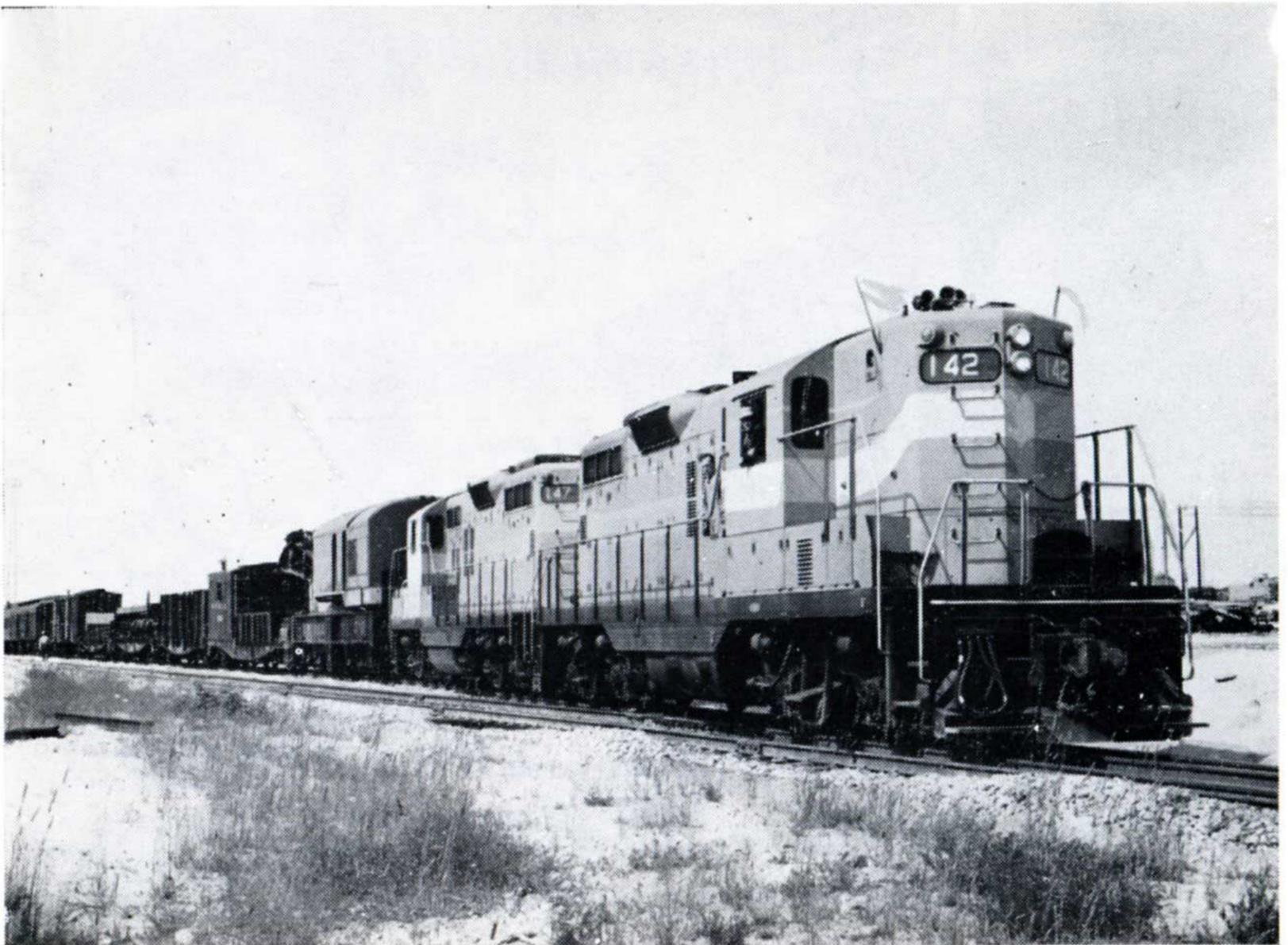
Une des 74 locomotives Diesel-électriques G.P. 9 R de 1.750 ch.
