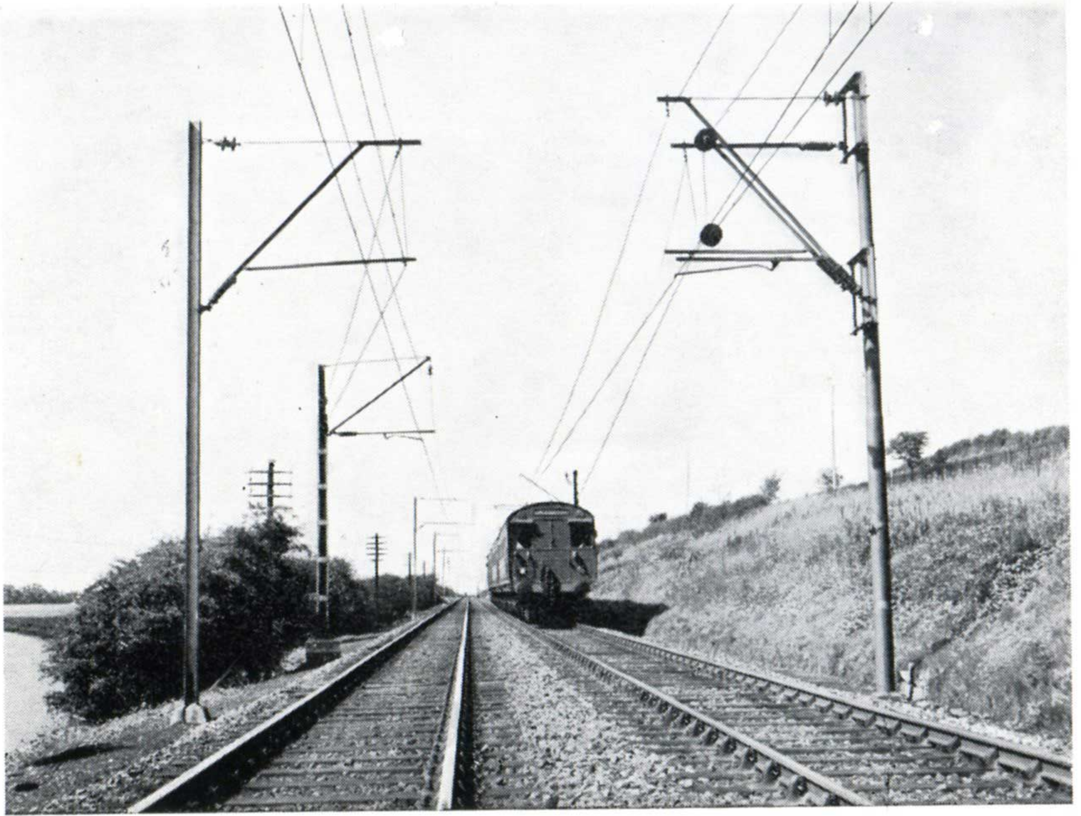
Sur la ligne Lancaster-Morecambe-Heysham, une automotrice triple en essai sous la caténaire expérimentale 6600 V 50 Hz. ( Photo British Railways L.M.R.)
