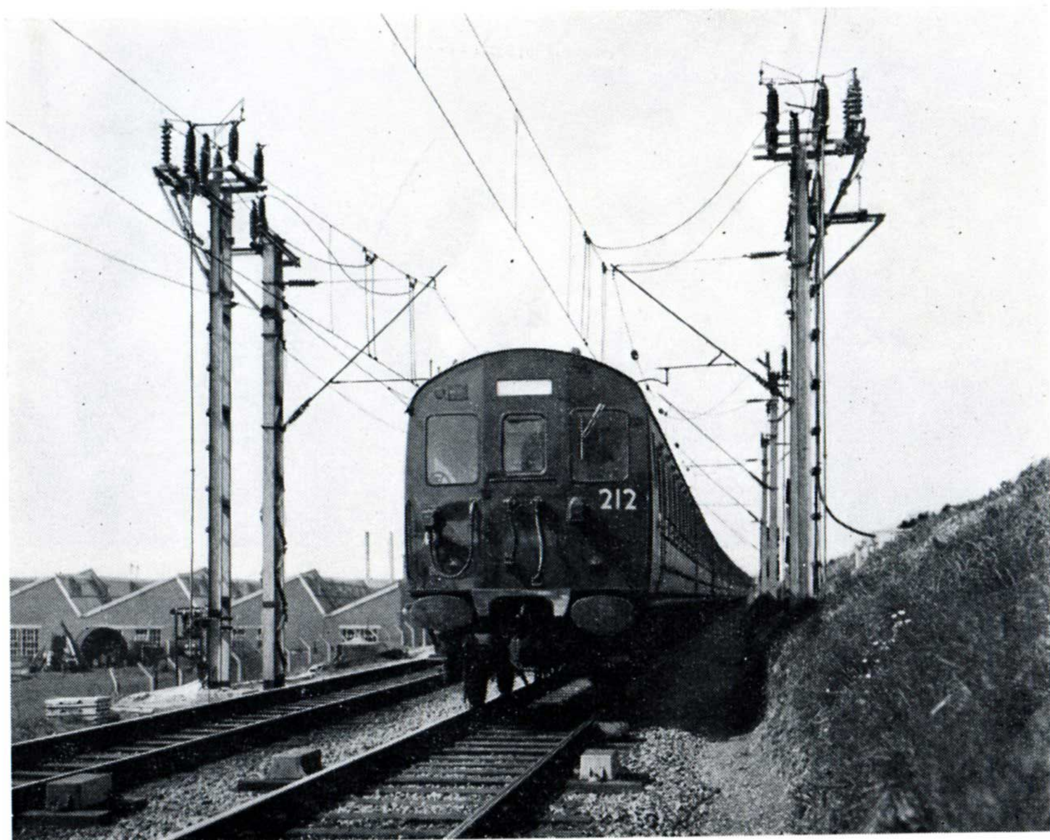
Un train vient de quitter Colchester et franchit une section neutre ; on remarquera, à l'avant plan, les boîtiers inducteurs de l'A.P.C. (Photo British Railways E.R.)
