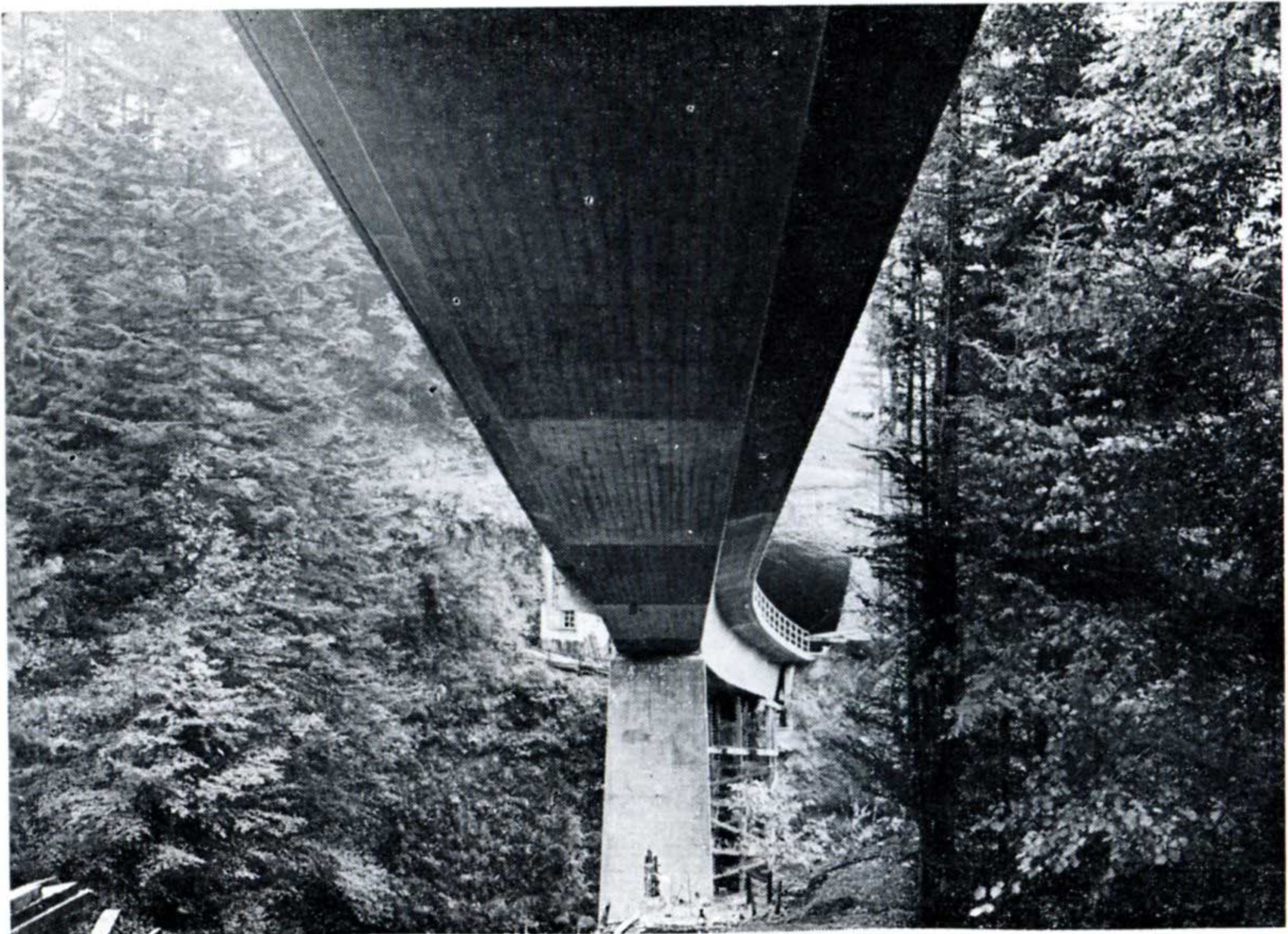
Le nouveau pont après décoffrage ; on remarquera la pureté des lignes. (Clichés « Les Transports Publics »)
