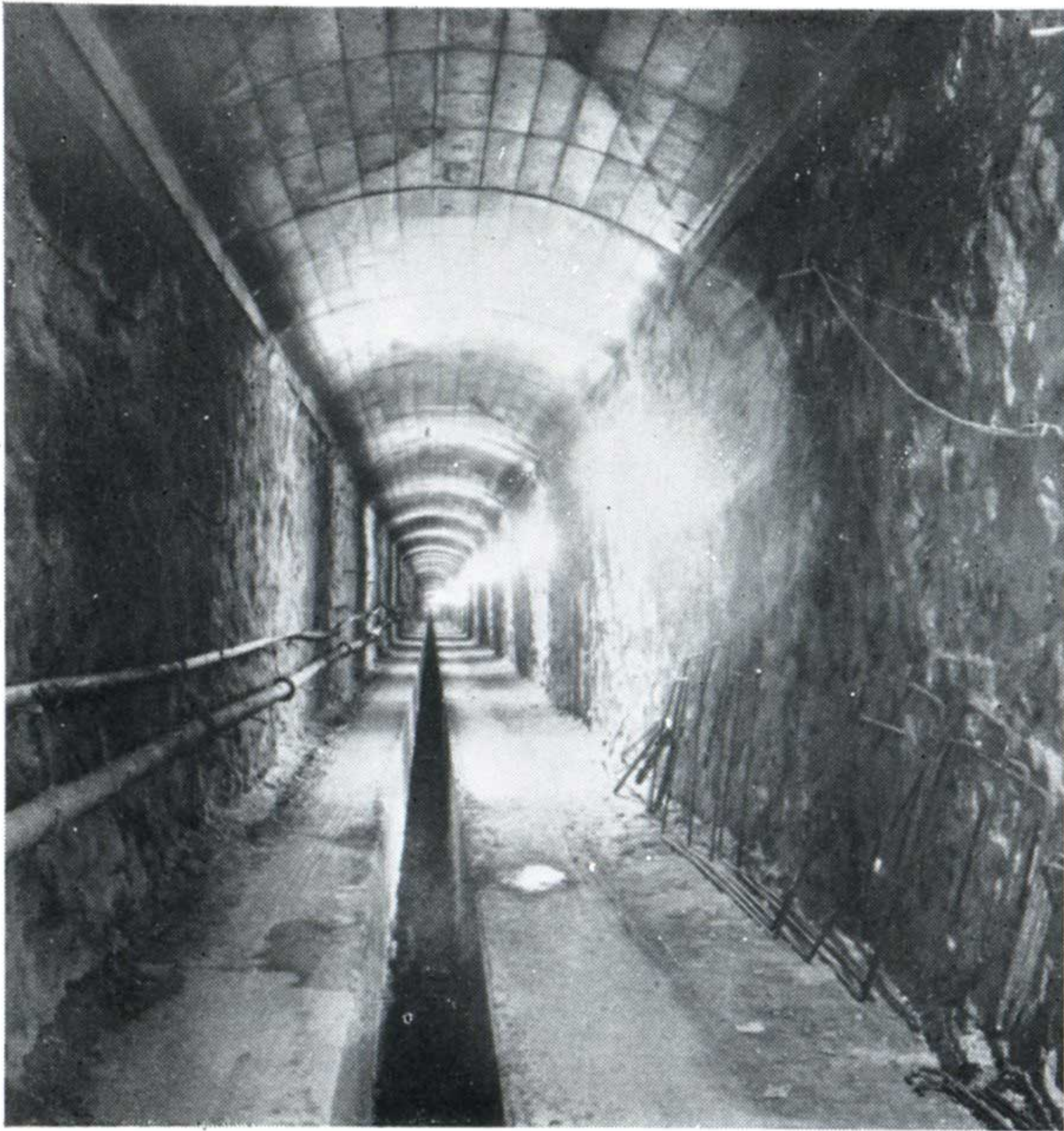
Fig. 2. — Le tunnel en construction ; on distingue au centre, le caniveau des câbles.
