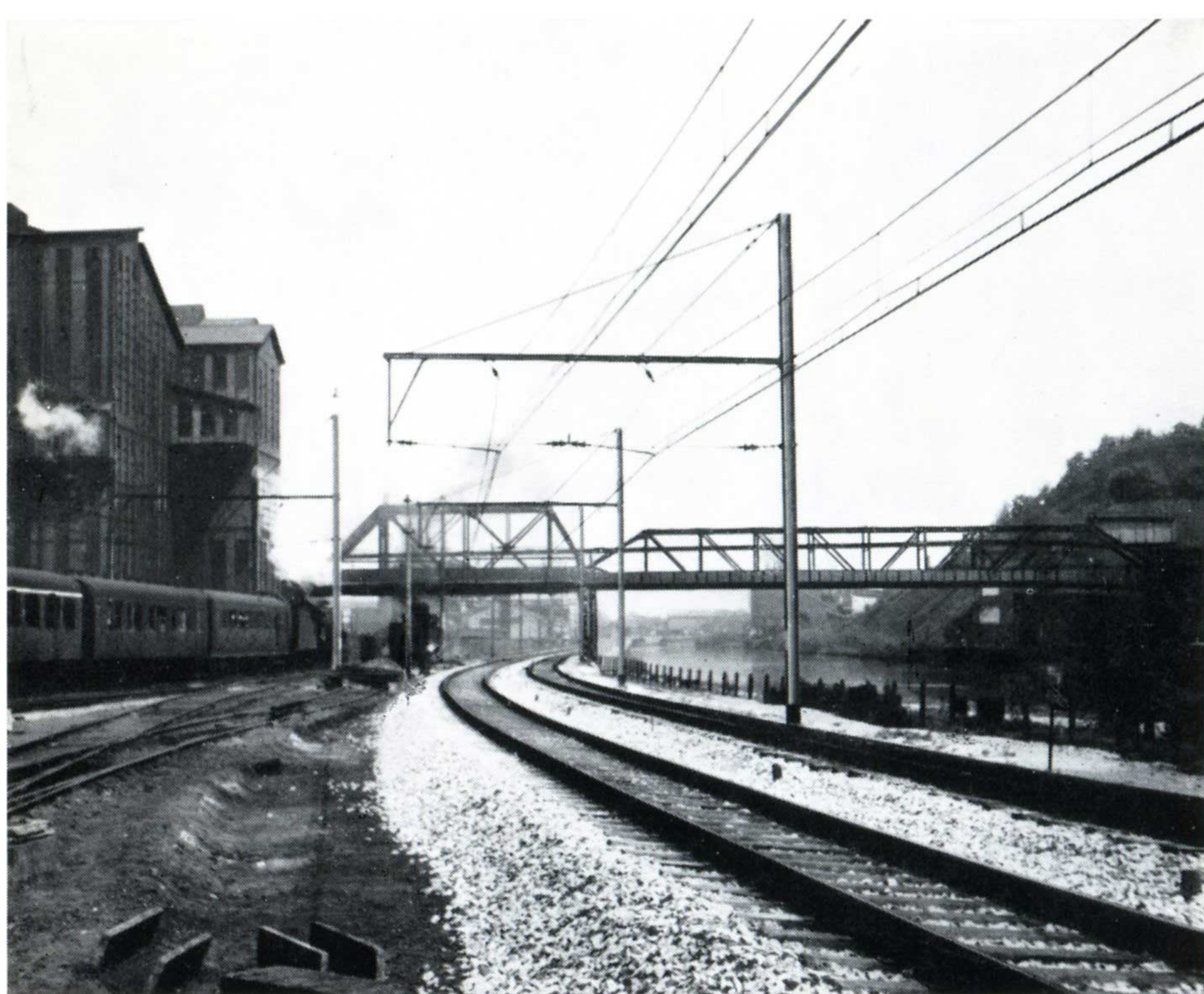
La ligne Charleroi-Namur est sous caténaire — photo prise quelques jours avant l'inauguration — à gauche, un train de voyageurs encore à traction à vapeur. (Cliché Ed. Sextant)
