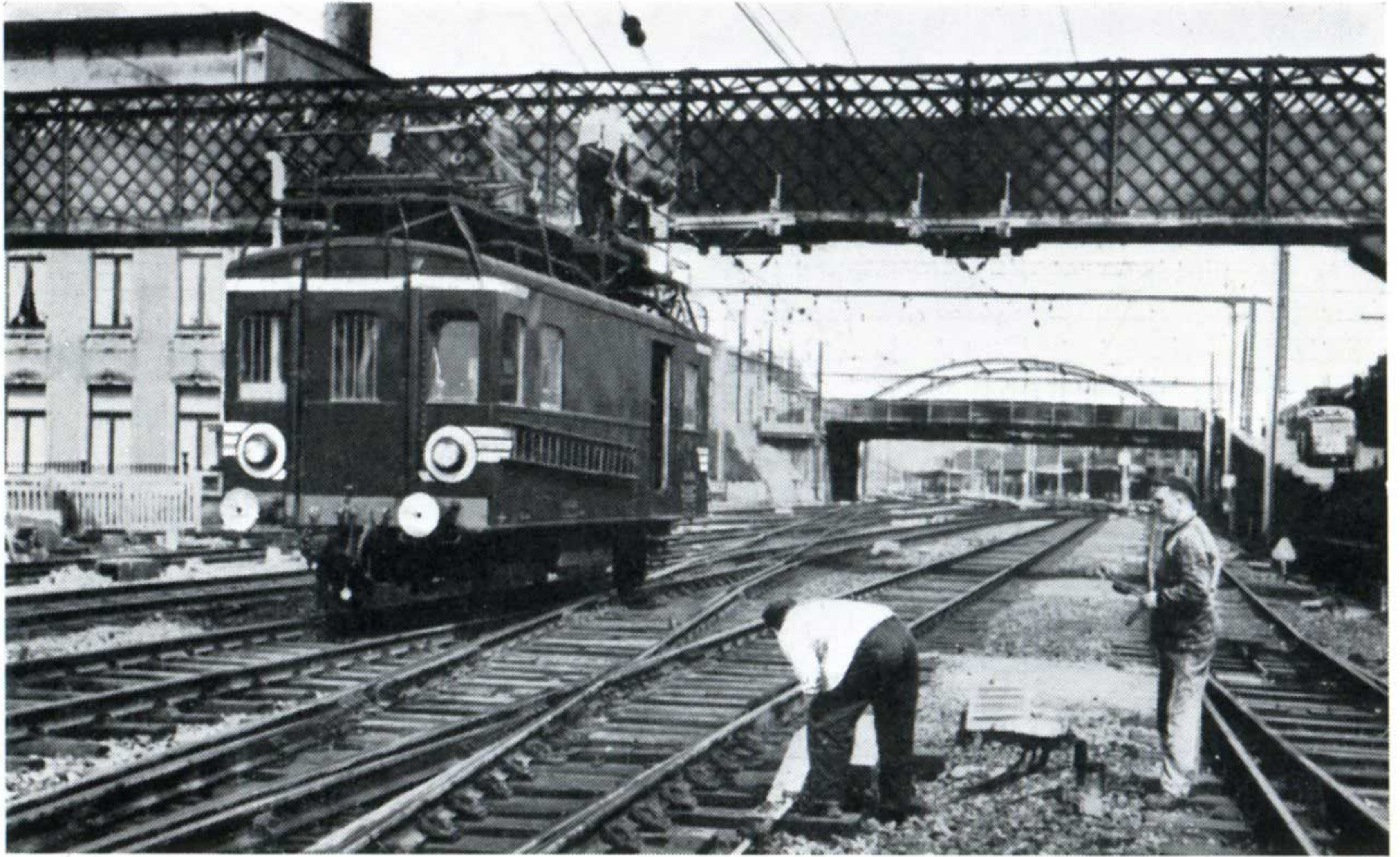
A Châtelineau, réglage de la caténaire avant la mise sous tension. (Photo B. Dedoncker)
