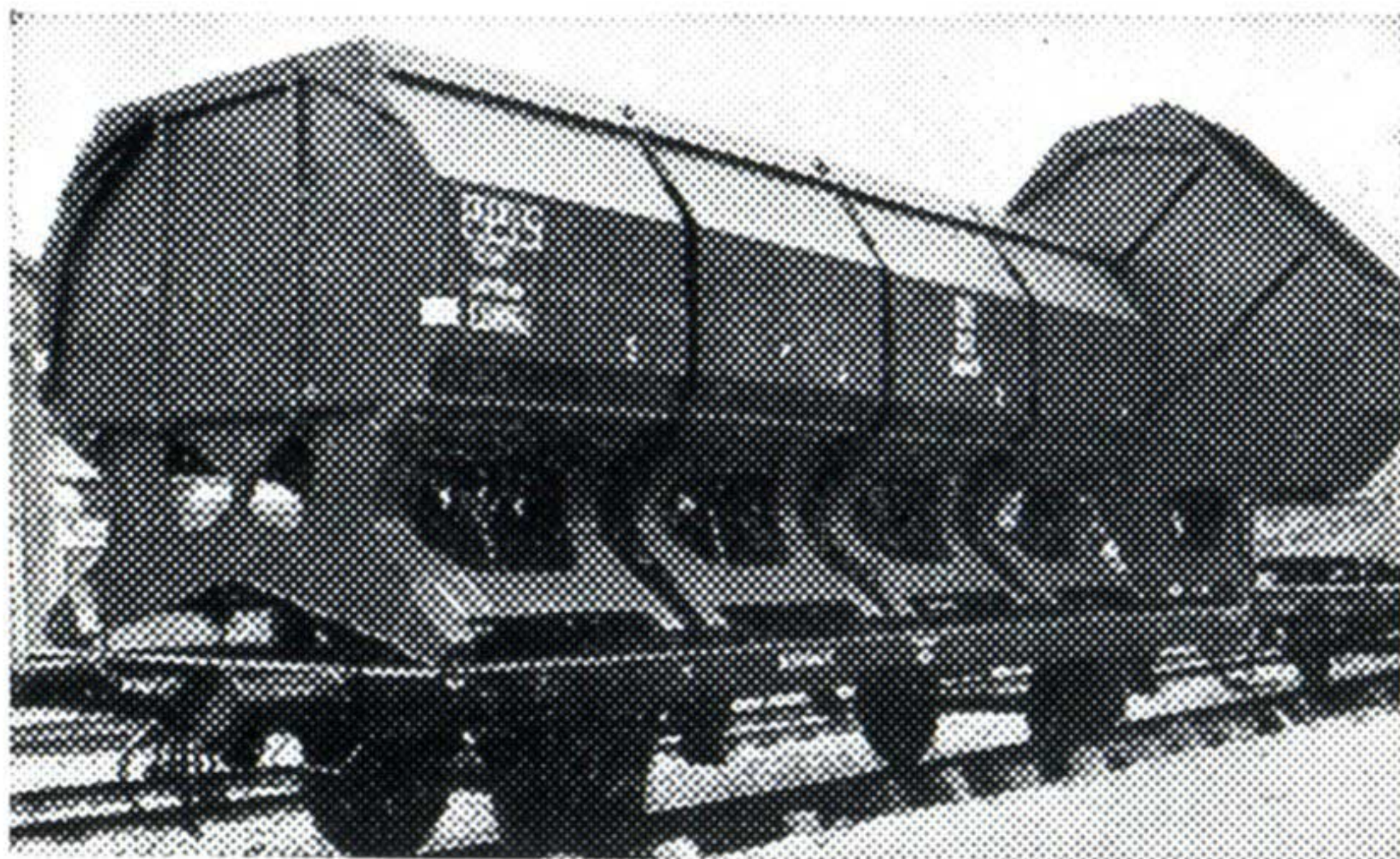
Fig. 6 — Wagon à bennes basculantes Omni II (Photo D.B.)
