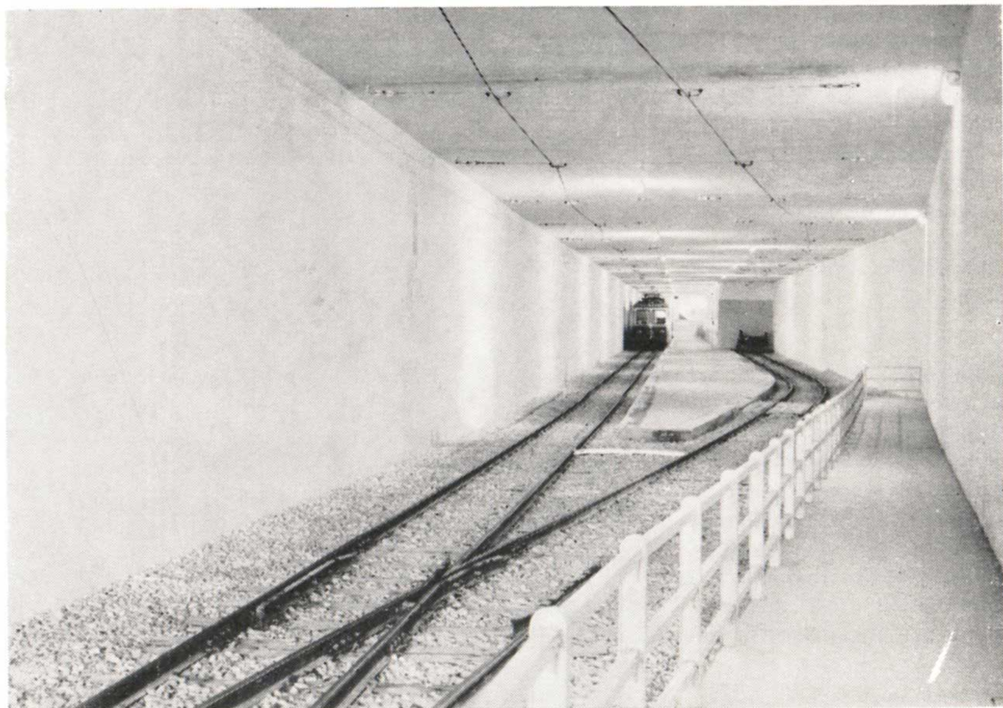
La nouvelle gare souterraine de Domodossola.
