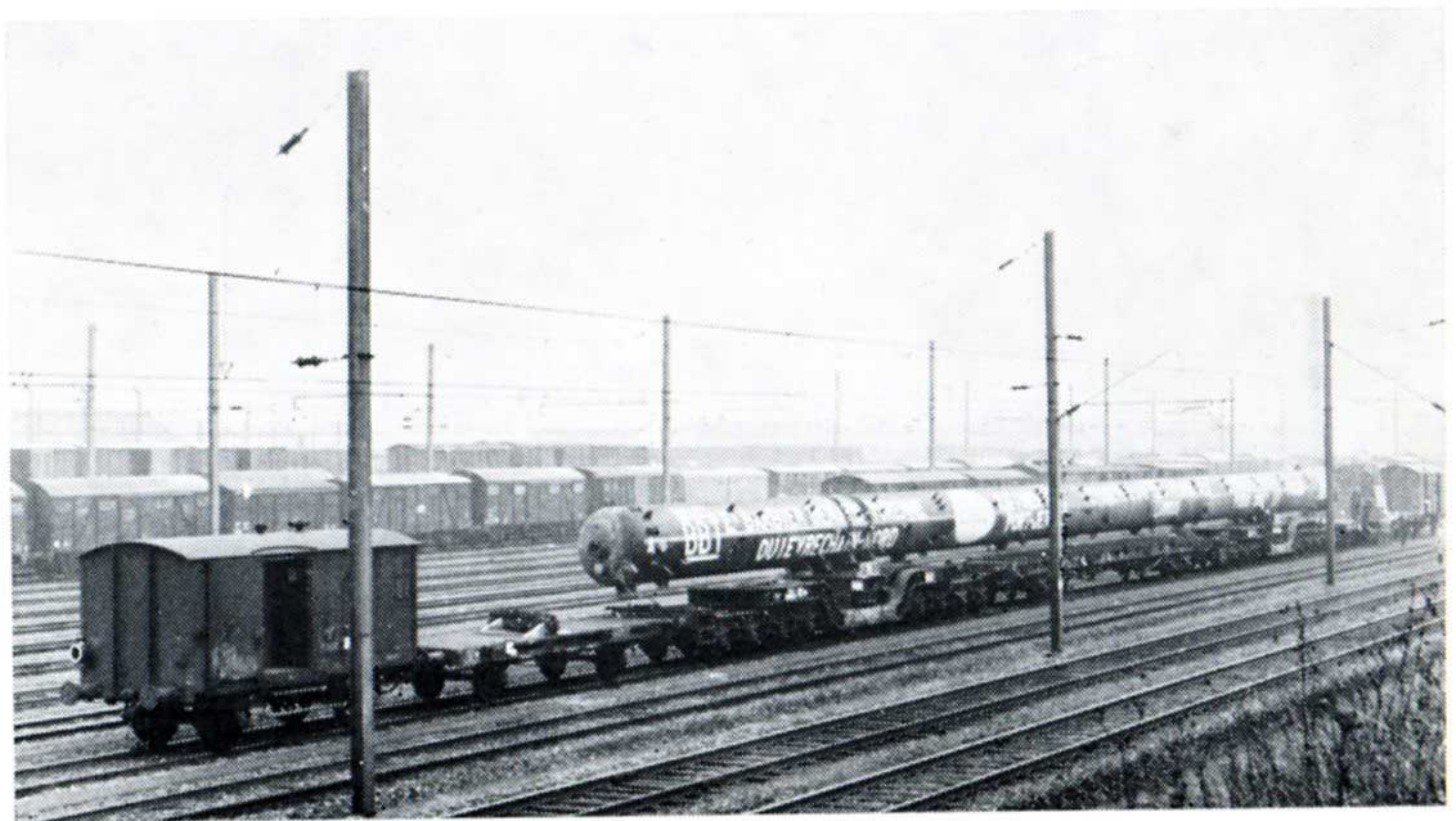
La tour de raffinage de 60 m en cours de transport sur le réseau de la S.N.C.F. (Photo S.N.C.F.)
