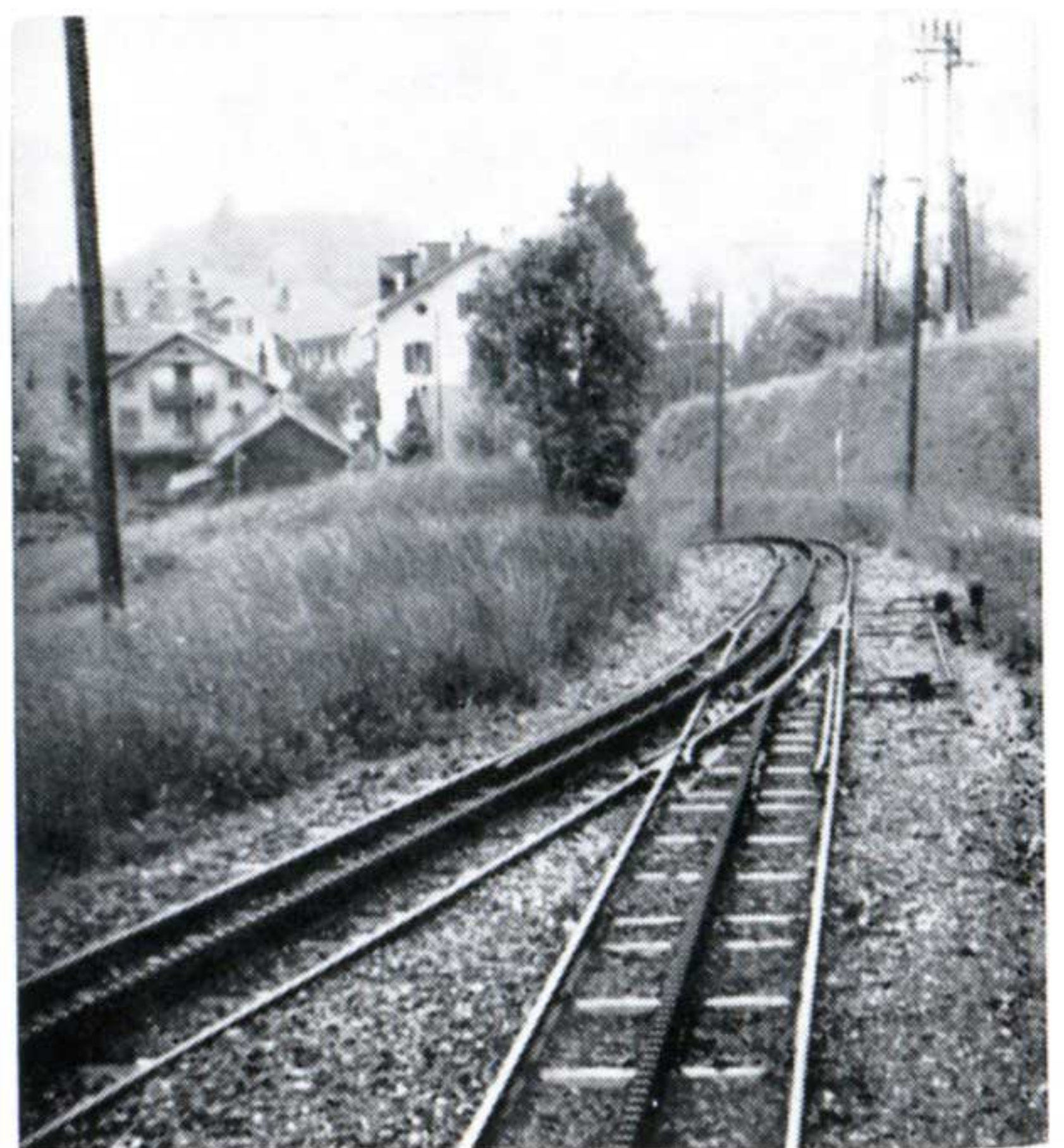
Ci-dessus, un aiguillage à crémaillère. (Photo de l'auteur)
