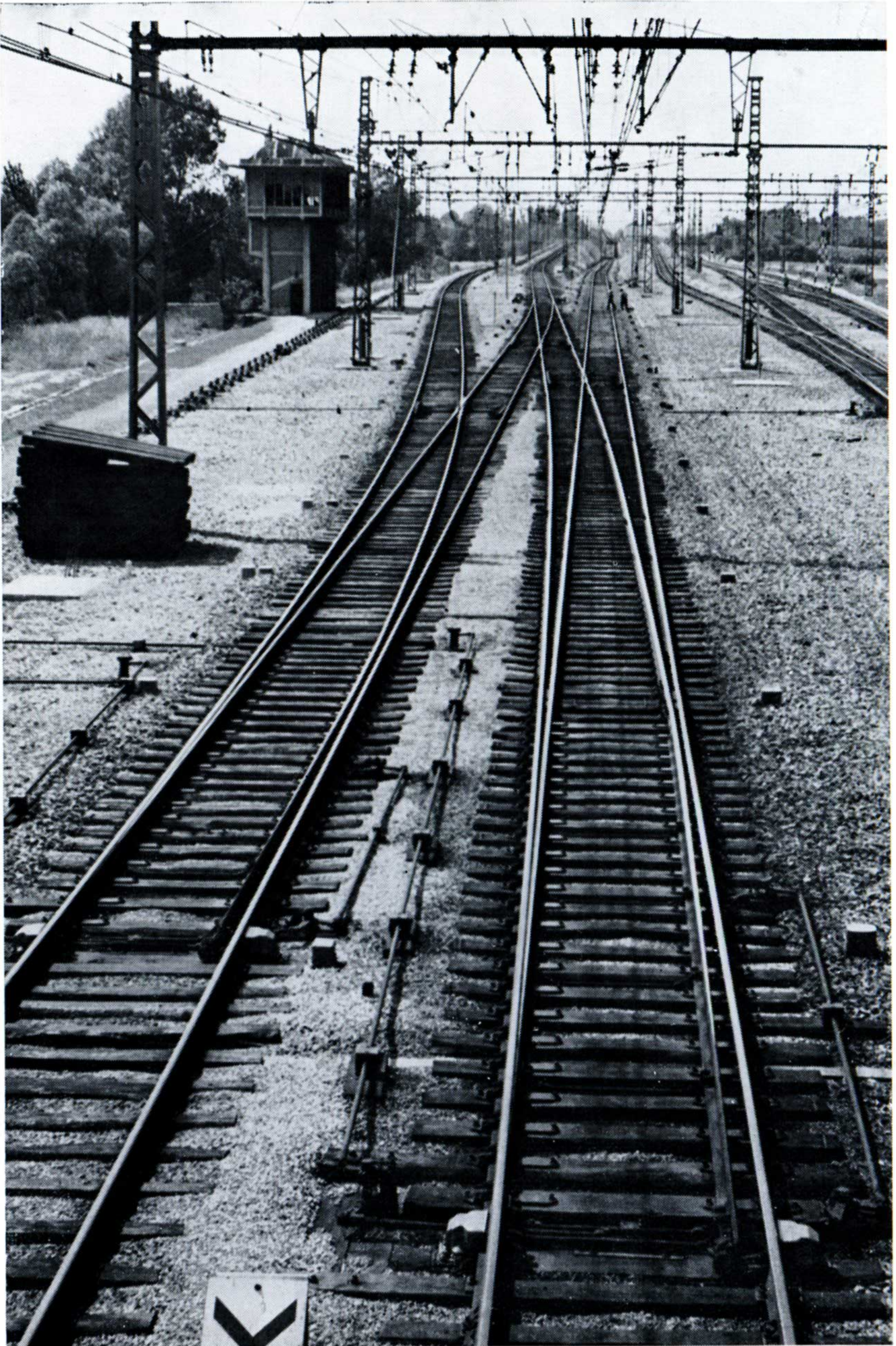
Figure 17 — Sur la ligne Paris-Lyon, appareil à tg. 003 au km 86 vers Lyon.
