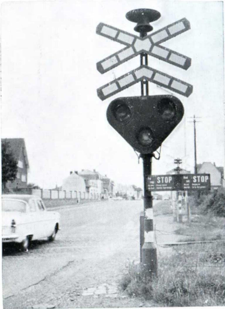
Passage à niveau avec signalisation lumineuse automatique sur ligne à double voie — signal routier à trois feux.
