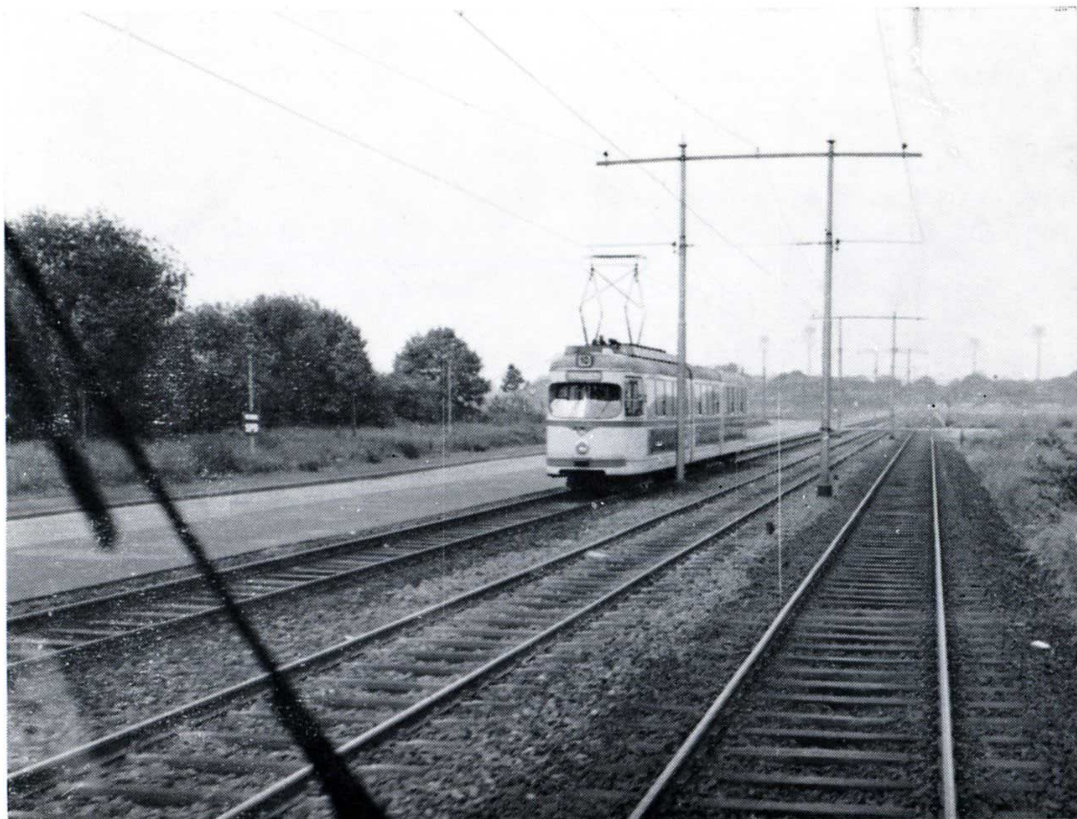
A Düsseldorf, site propre à trois voies à proximité du stade ; la voie centrale est banalisée et sert au transport dans le sens le plus chargé. (Photo R. M. Vandermar)
