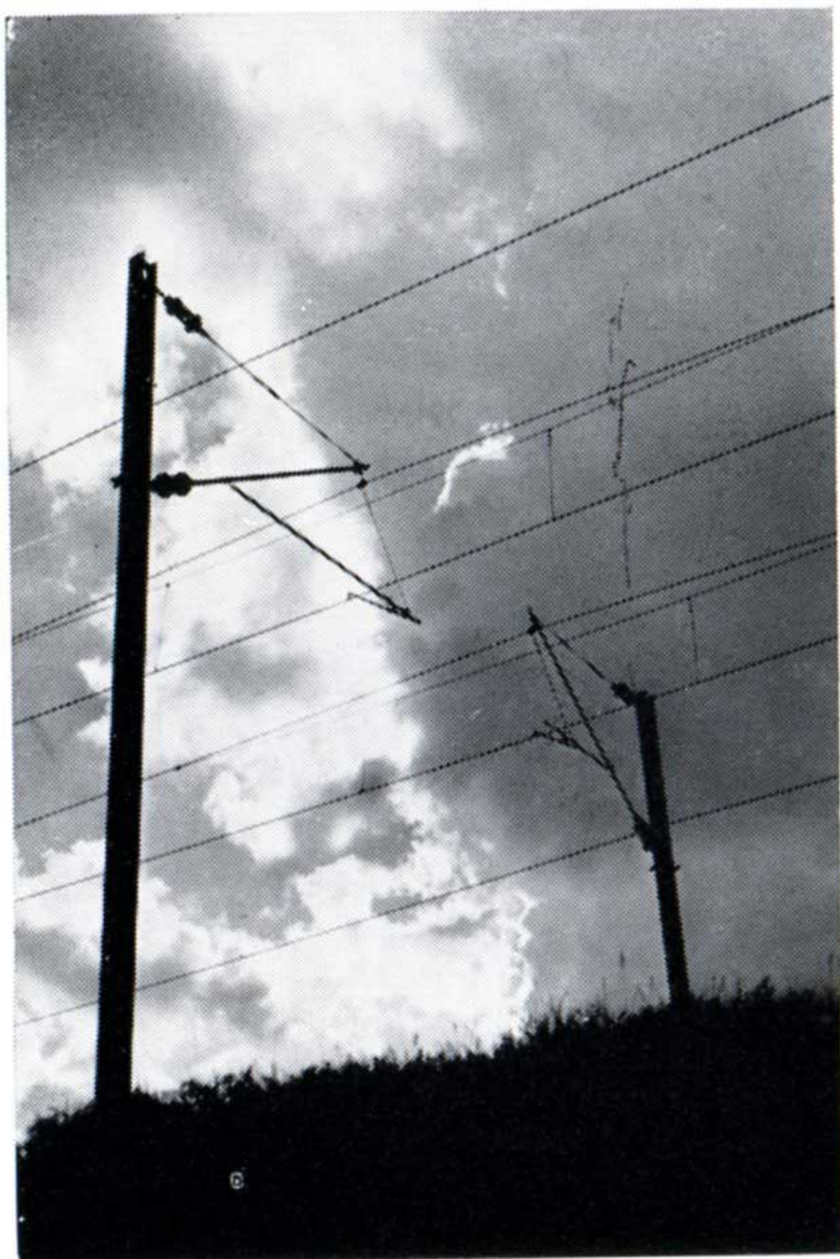
Caténaire S.N.C.F. — 25.000 volts 50 Hz. (Photo S.N.C.F.)
