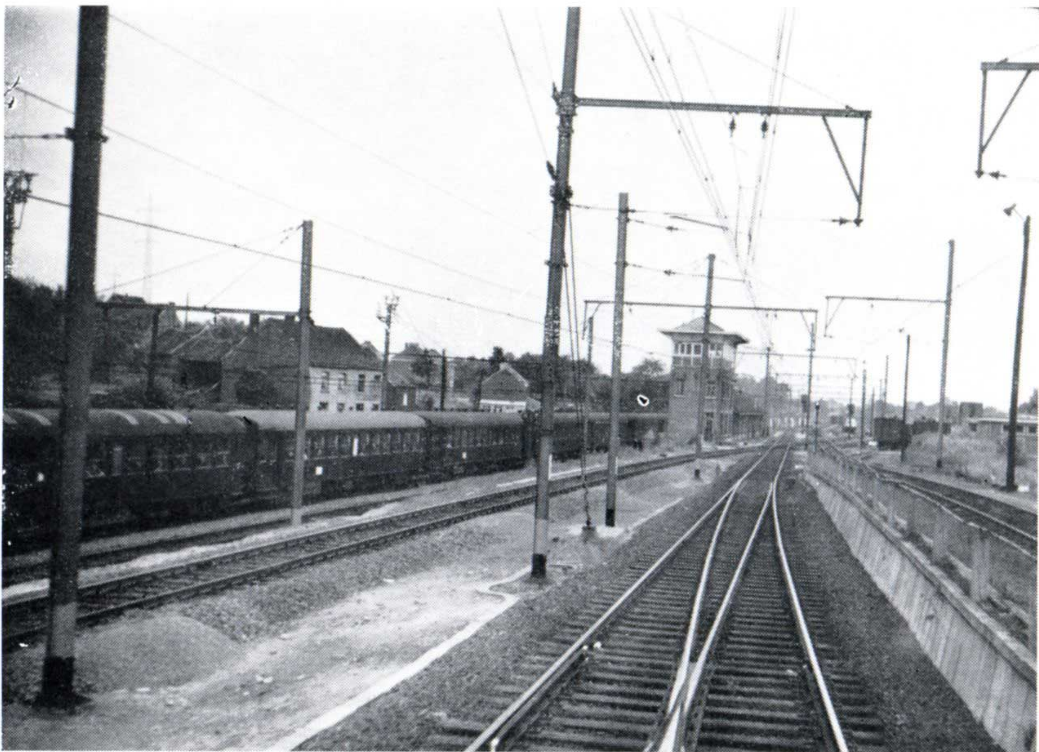
Entre Bruxelles et Hal, raccordement de la 3ème voie banalisée. (Photo B. Dedoncker)
