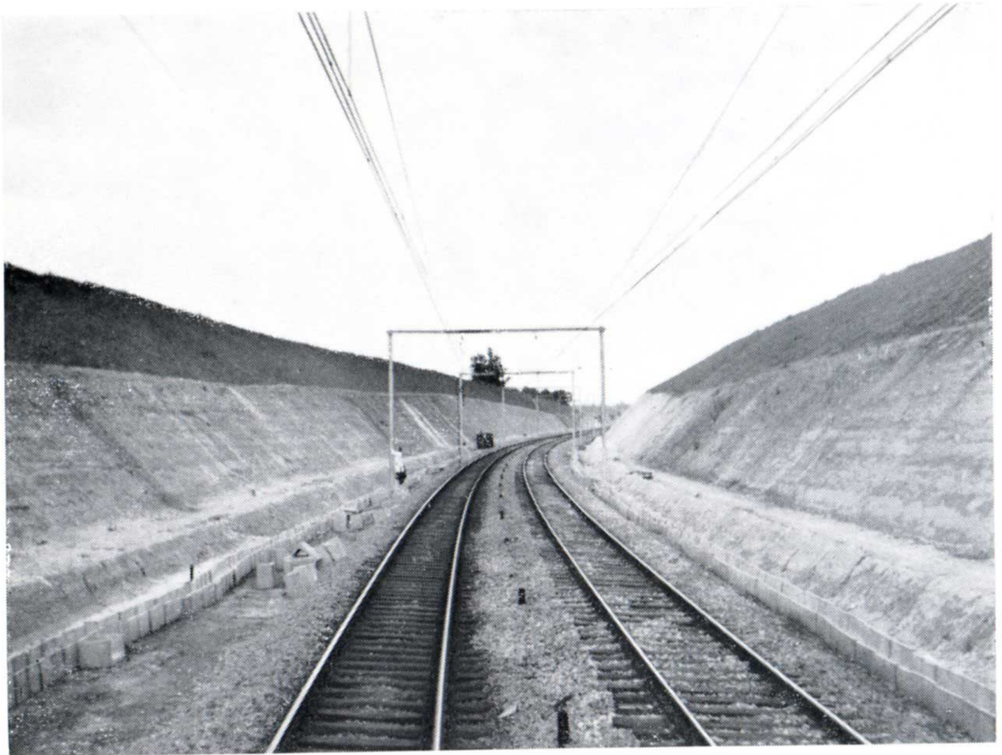
Nouvelle ligne Mons-Frarneries sous caténaire 3.000 volts.
