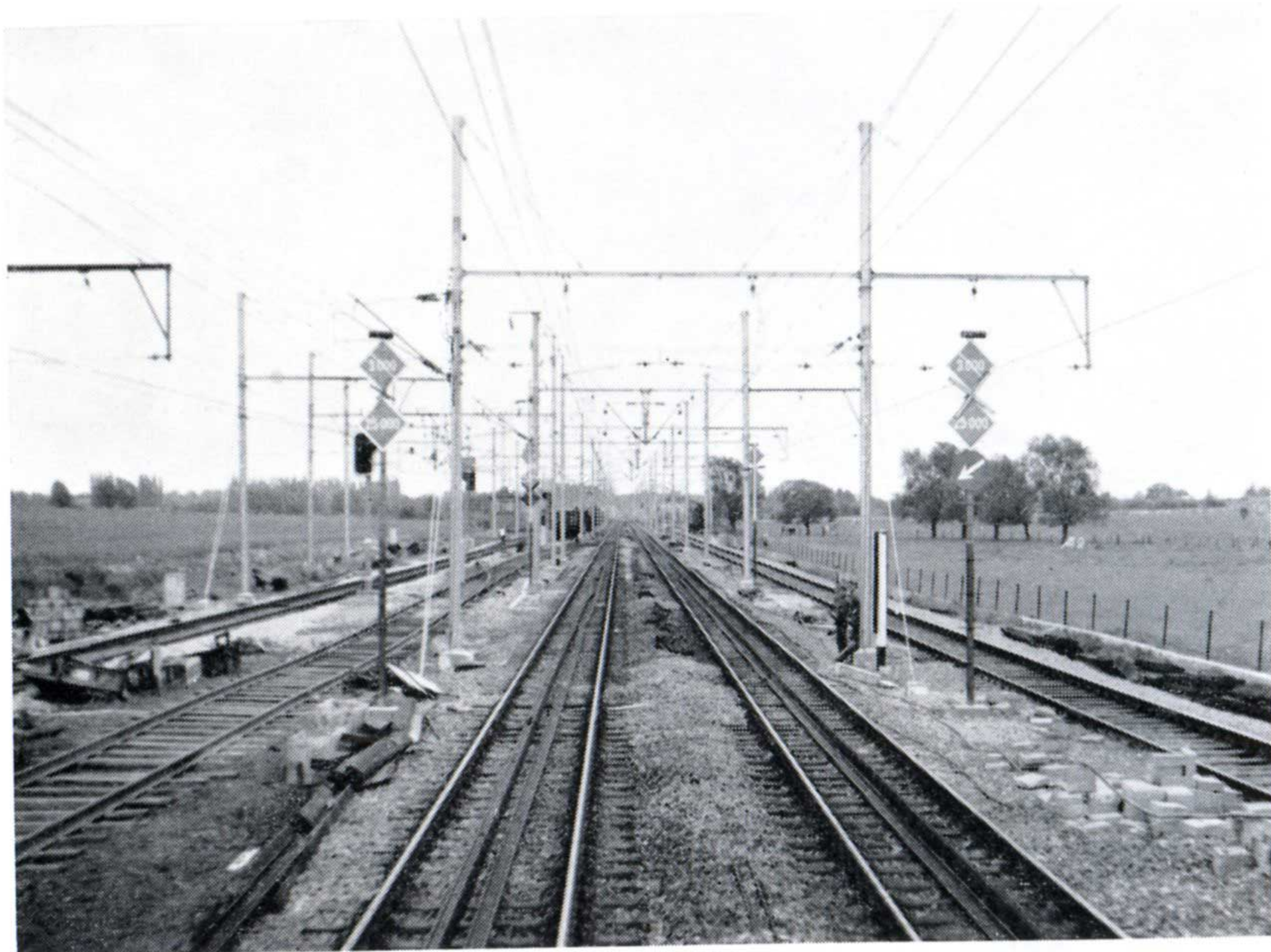
La section neutre sur voies principales à Quévy, vue prise vers la France — on distingue, de part et d'autre, les voies secondaires en 3.000 volts courant continu. (Photo B. Dedoncker)
