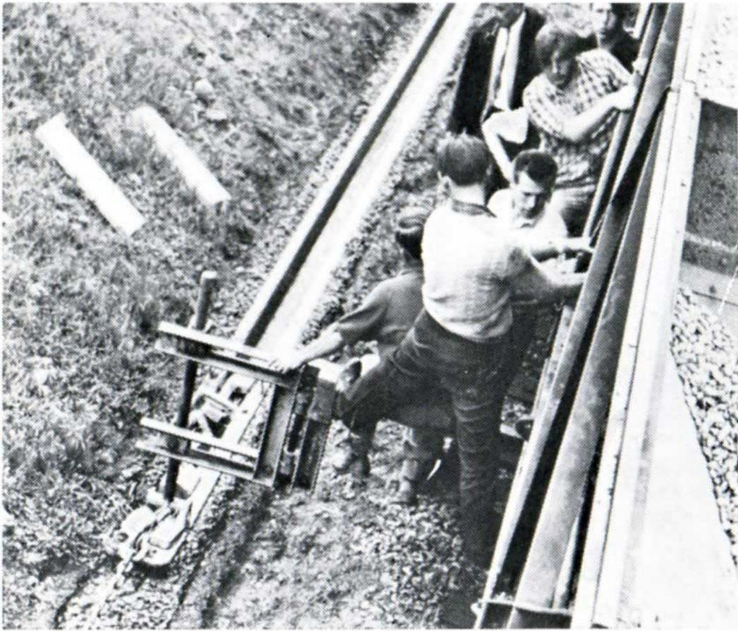
Construction d'un caniveau en béton en continu à partir d'un train en marche.
