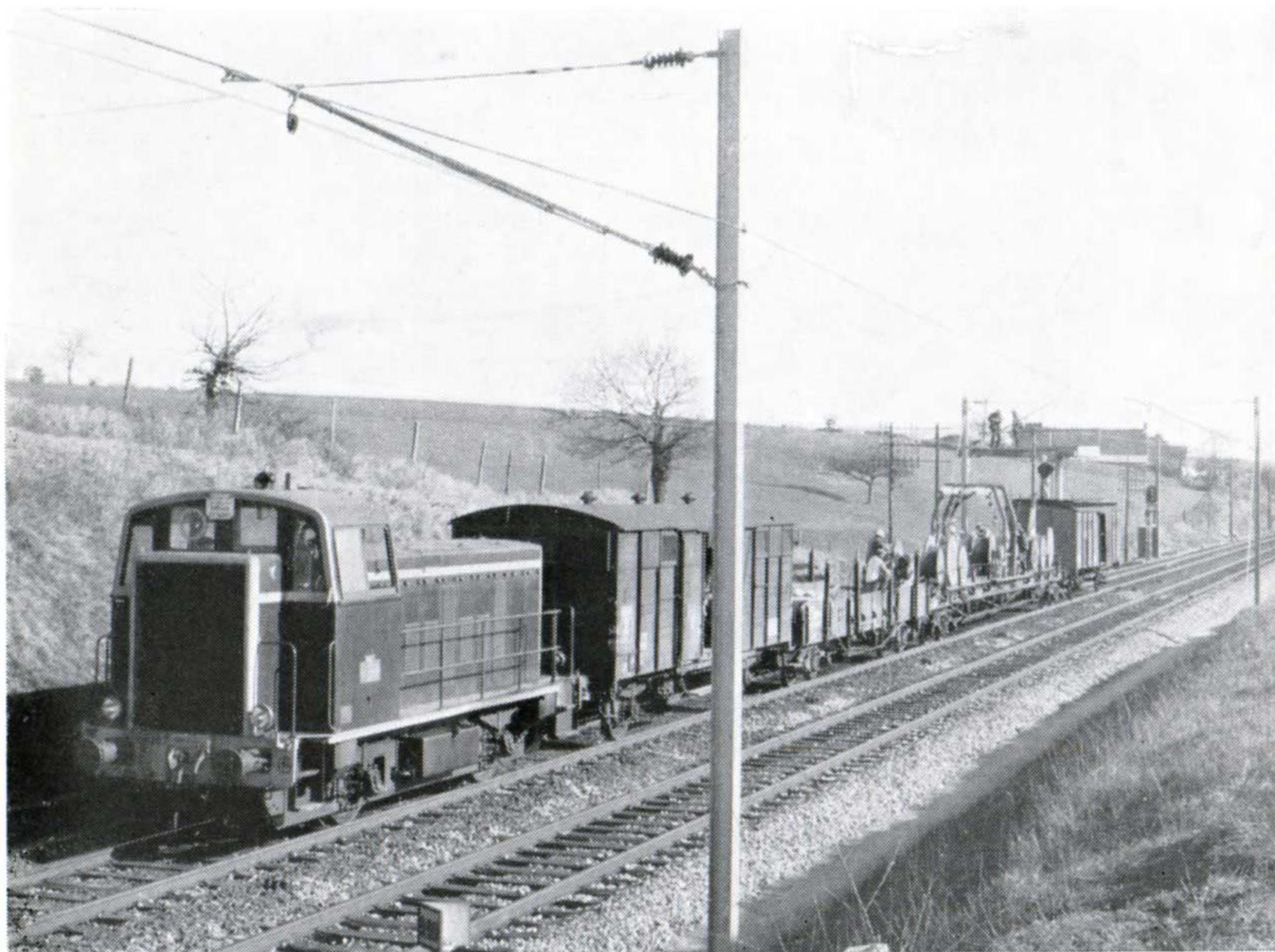
Travaux d'électrification — train dérouleur remorqué par un locotracteur Y 51.200 Diesel de la S.N.C.F. (Photo S.N.C.F.)
