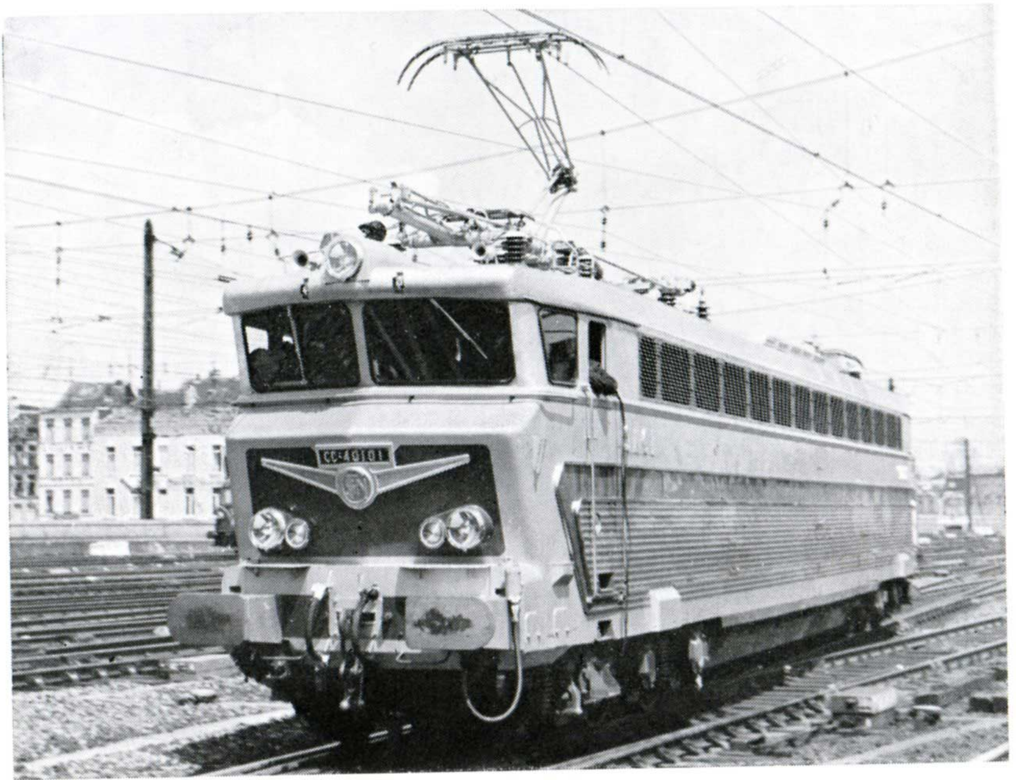
Locomotive quadricourant CC type 40.100 de la S.N.C.F. (Cliché A.R.B.A.C., photo B. Dedoncker)
