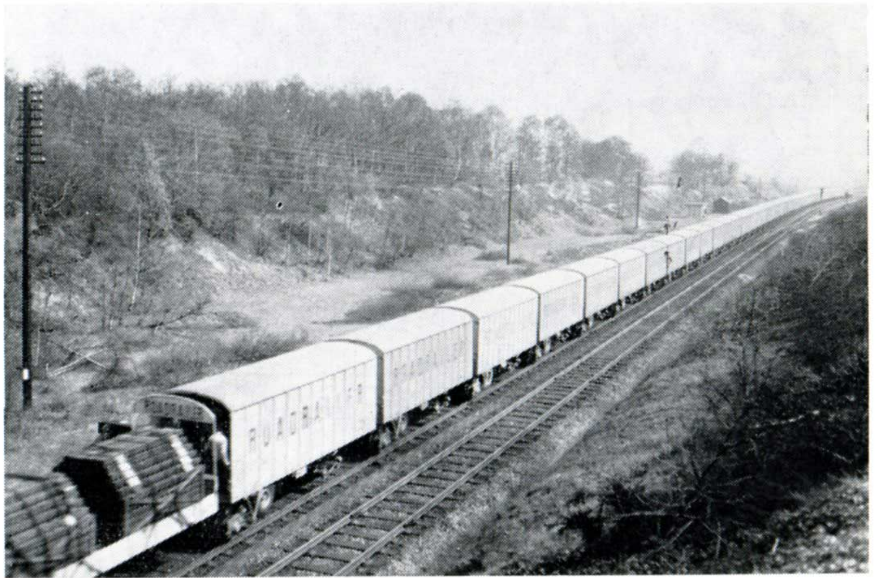
Un train de remorques rail-route en Grande-Bretagne. (Photo Pressed Steel)
