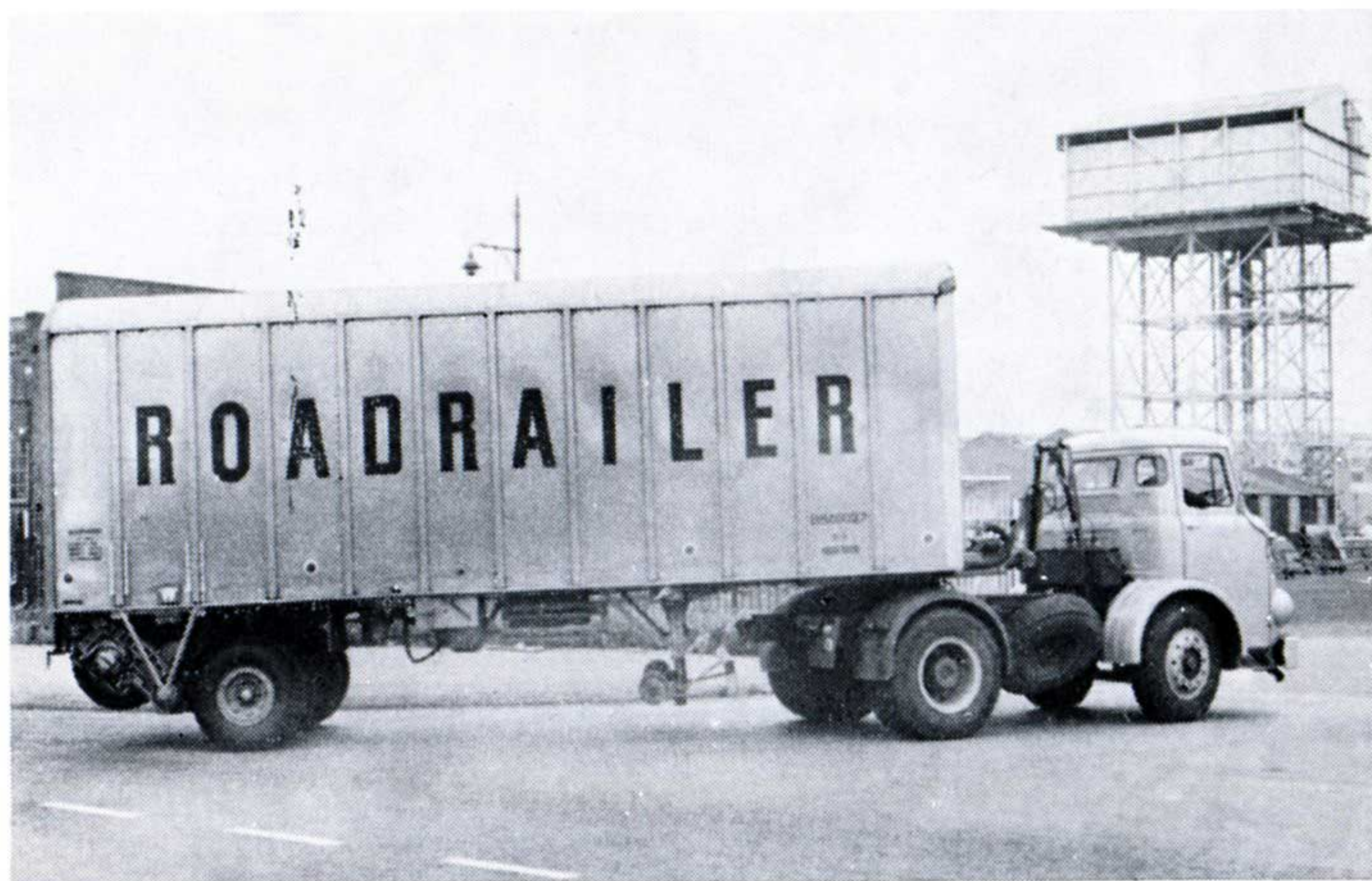
Une remorque rail-route en position route.
