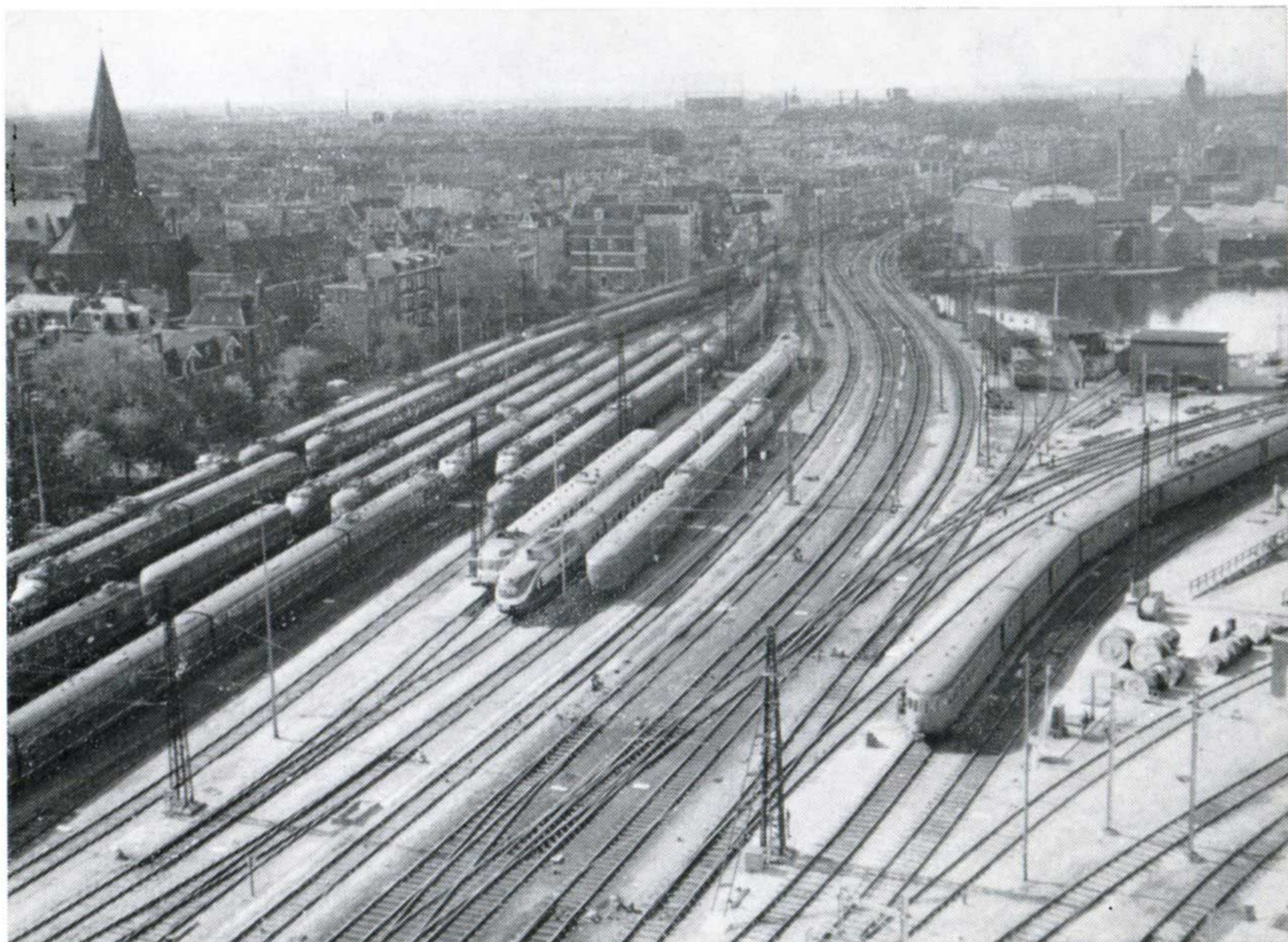
Vue aérienne partielle de la gare centrale d'Amsterdam.
