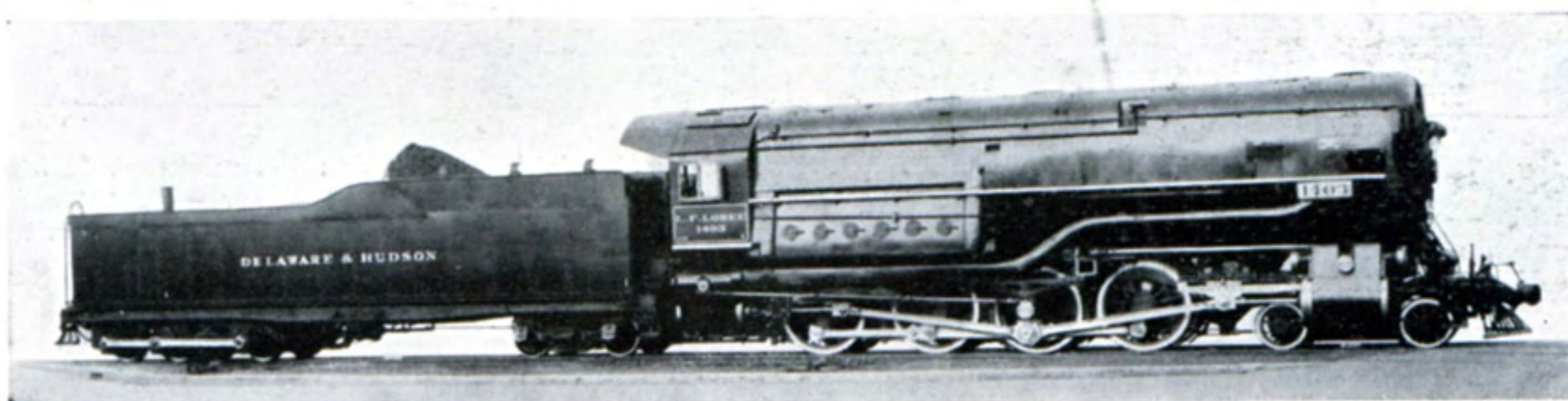
Fig. 183 DELAWARE & HUDSON RAILROAD, ETATS-UNIS. Essieux moteurs : 1 roulement I-114227 par boîte. Charge statique par boîte 19 tonnes.
