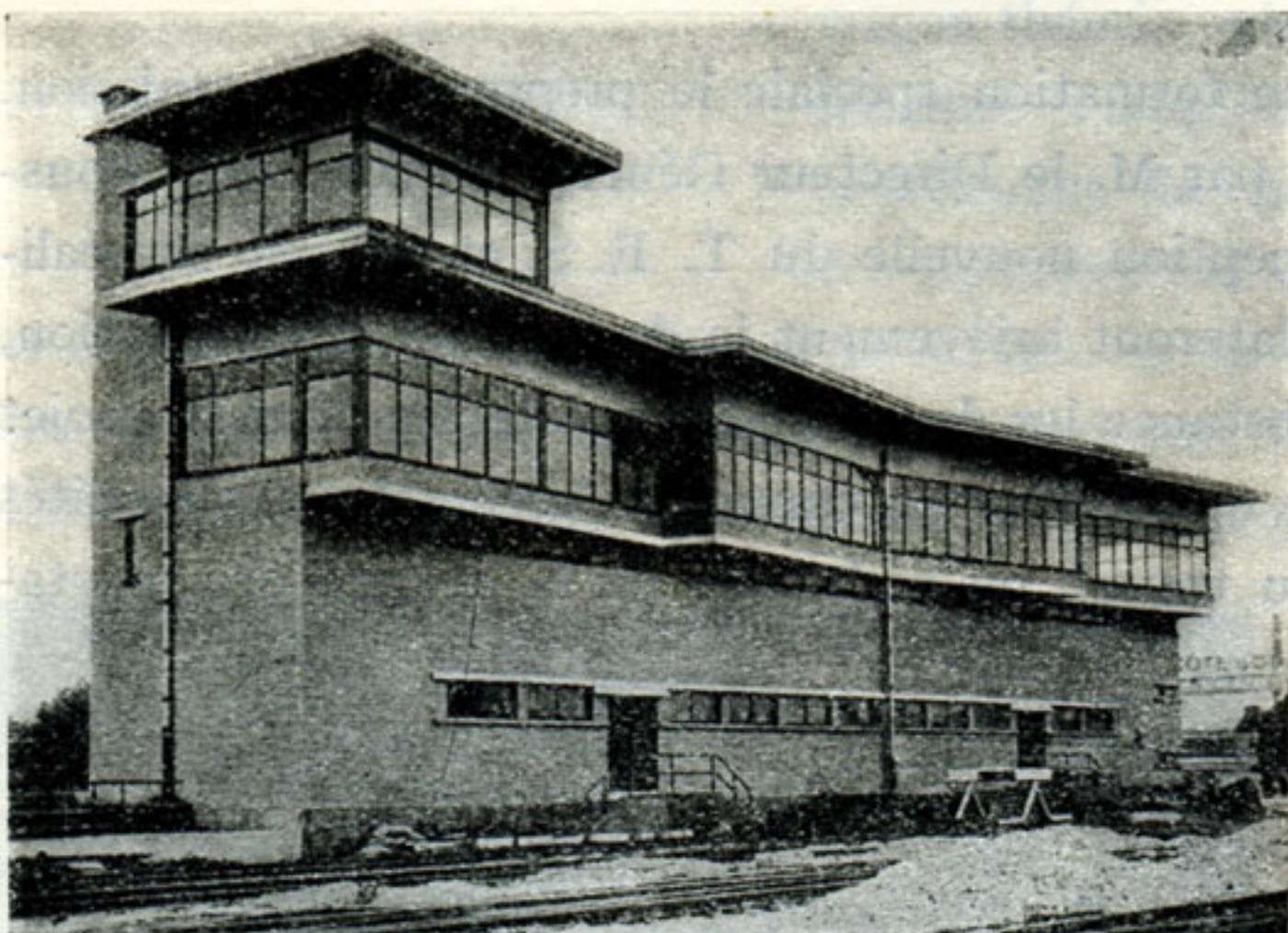
FIG. 7. — Extérieur cabine électrique.
