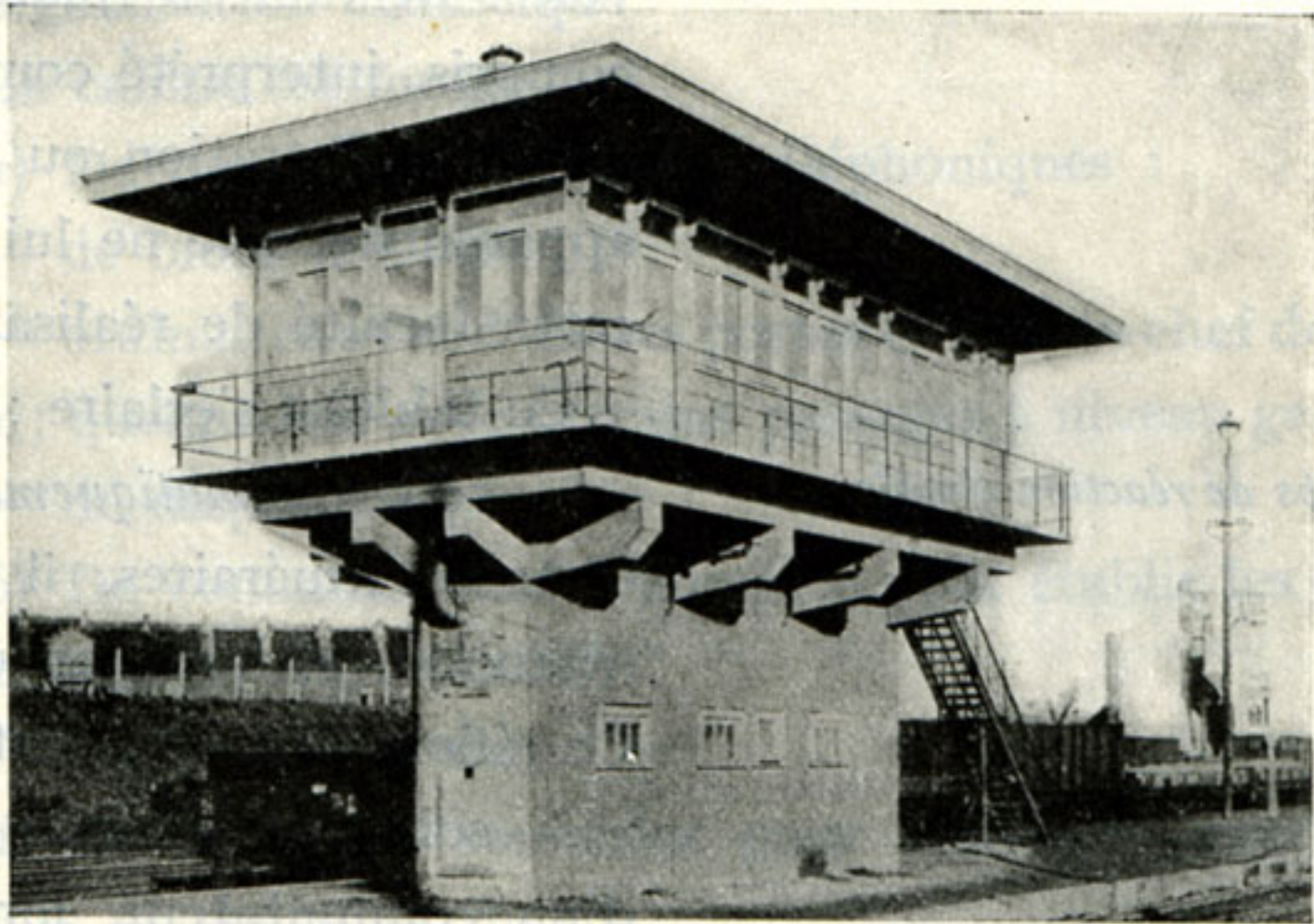
FIG. 10. — Extérieur cabine électrique.
