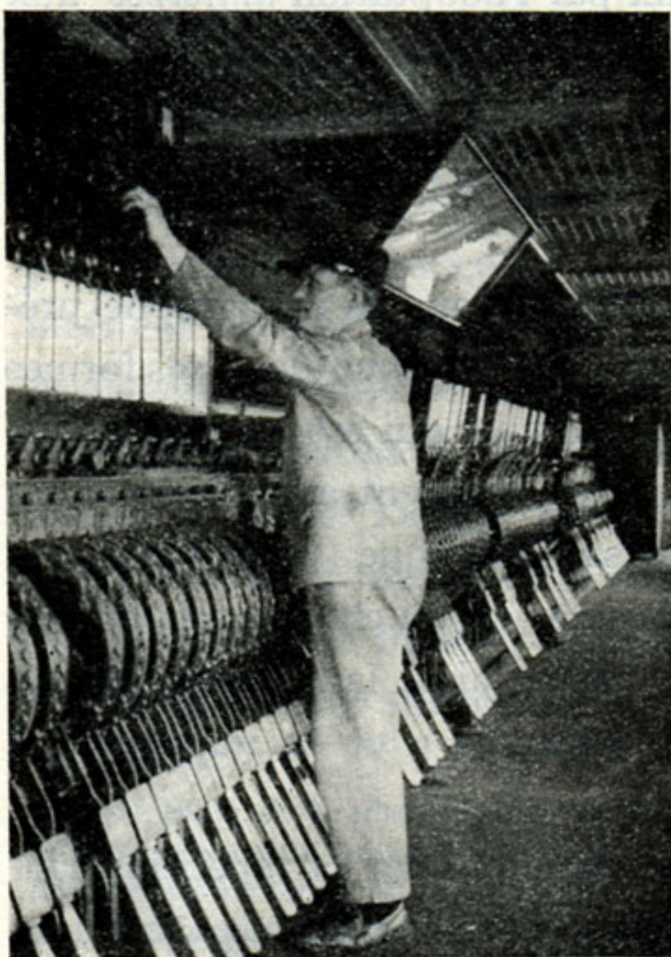
FIG. 13. — Intérieur cabine mécanique : signaleur au travail.
